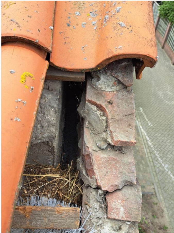
Figuur 10. Bovenste deel spouw beschikbaar gehouden.
