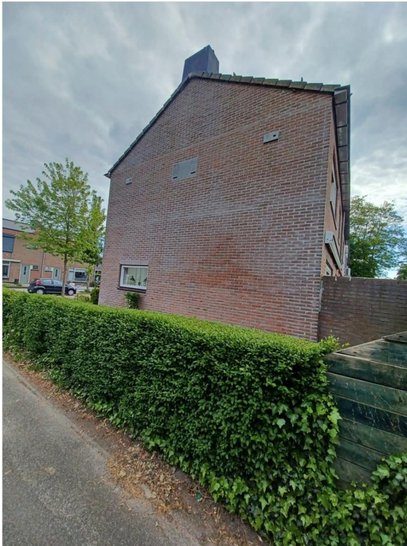
Figuur 9. Bovenste deel spouwmuur beschikbaar gehouden voor vleermuizen, daaronder inbouwkasten.
