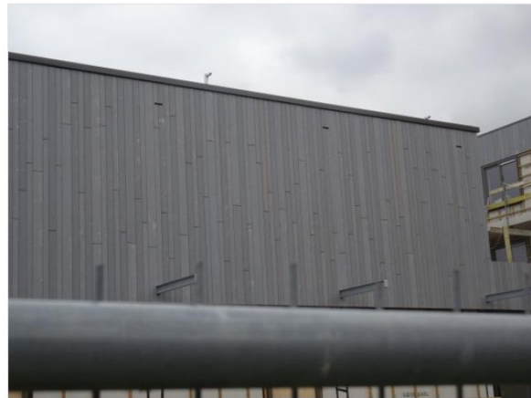
Figuur 8 Ingebouwde vleermuiskasten in de westelijke gevel bij de nieuwbouw.
