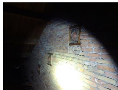
Figuur 3 Alle gaten zijn geblokkeerd door rasters met gaas.
