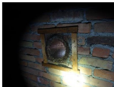
Figuur 2 Vooraanzicht van de rasters voor de ingangen bij de zolder.
