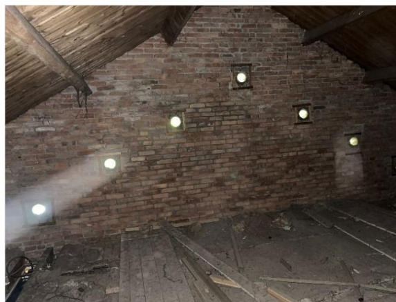
Figuur 4.5 Van binnenuit rasters voor de gaten die toegang tot de zolder belemmeren.
