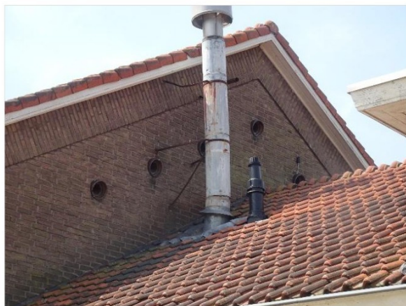
Figuur 4.4 Openeringen in de gevel naar de zolder boven de gymzaal.
