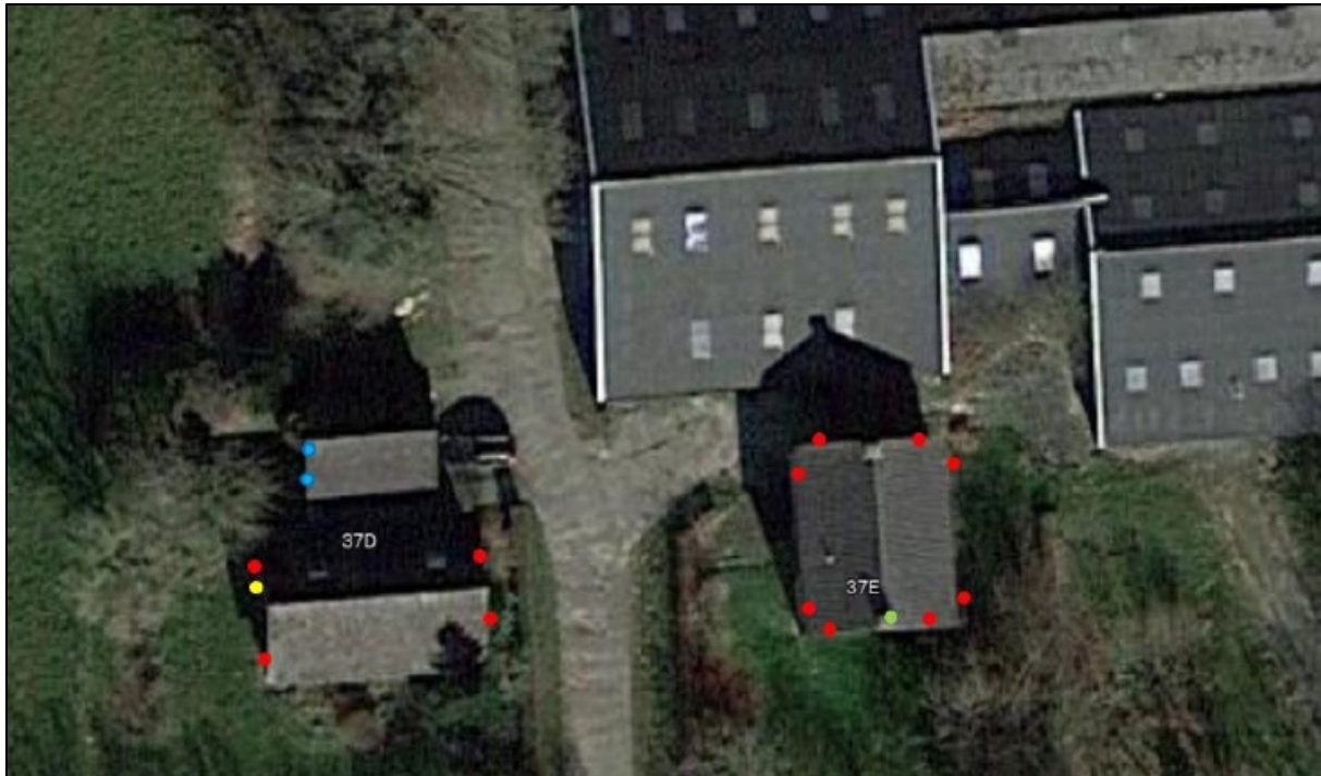
Figuur 3: De locaties van de aangebrachte voorzieningen. De open stootvoegen in de gevels van de woningen (rode stippen), open stootvoegen in de garage met hierachter een gevelbetimmering (blauwe stippen), meerlaagse gevelbetimmering buitenzijde (gele stip), inbouwkasten in combinatie met betimmering (groene stip)
