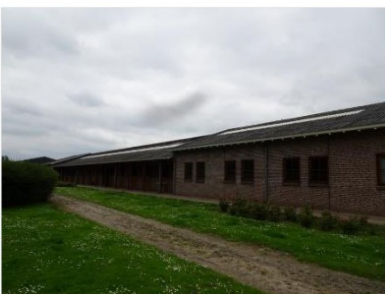
Figuur 2.6 Onderzoekslocatie gezien vanaf het zuiden.
