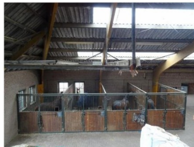
Figuur 2.4 Binnenkant van de onderzoekslocatie.
