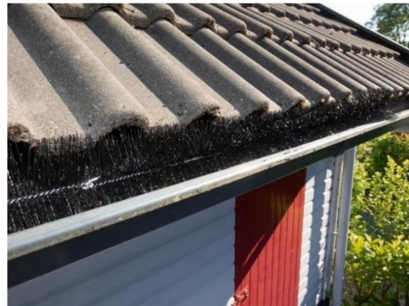
Figuur 8.8 Voorbeeld van toepassen spouwborstels in dakgoot.
