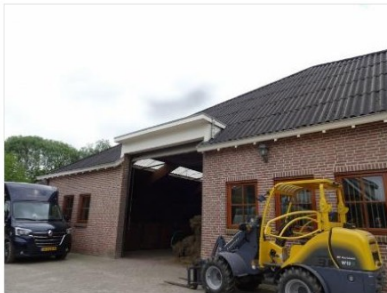
Figuur 1.3 Onderzoekslocatie gezien vanaf het westen.
