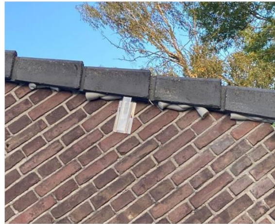
Figuur 8.10 Voorbeeld ongeschikt maken woning door exclusion flap tegen dakrand gecombineerd met vulschuim.
