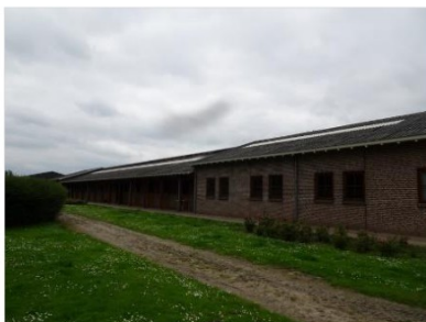
Figuur 1.6 Onderzoekslocatie gezien vanaf het zuiden.
