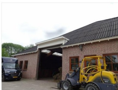
Figuur 2.3 Onderzoekslocatie gezien vanaf het westen.
