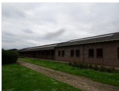
Figuur 2.6 Onderzoekslocatie gezien vanaf het zuiden.
