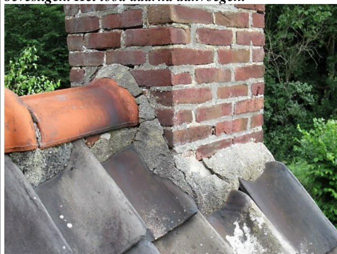
schoorsteen no. 3, noordzijde dak no. 4 (foto 2021)
