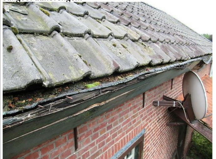
ingerot houtwerk goot no. 1 (foto 2021)
