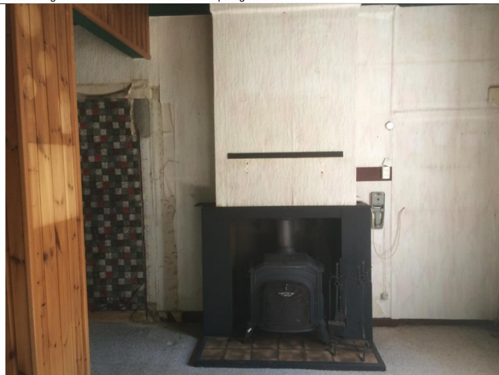
Bestaande woonkamer: Voorzetwanden verwijderen. Haard herstellen en behouden. Afwerkingen indifferent.
