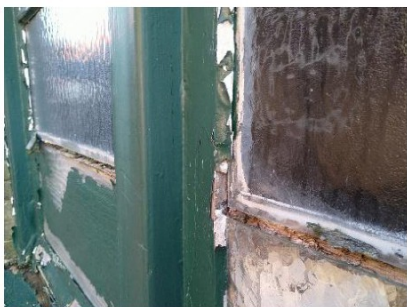
Kozijnen aangetast door houtrot
