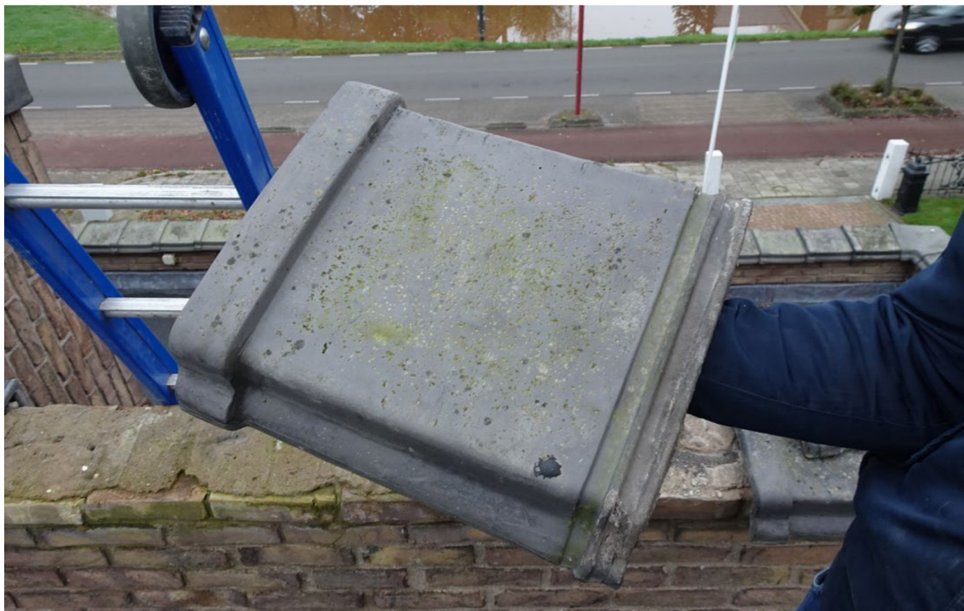
Keramieken afdekker welke voor een groot deel los zitten. Op de achtergrond zie je de mortellaag waar de afdekkers in zijn gezet.
