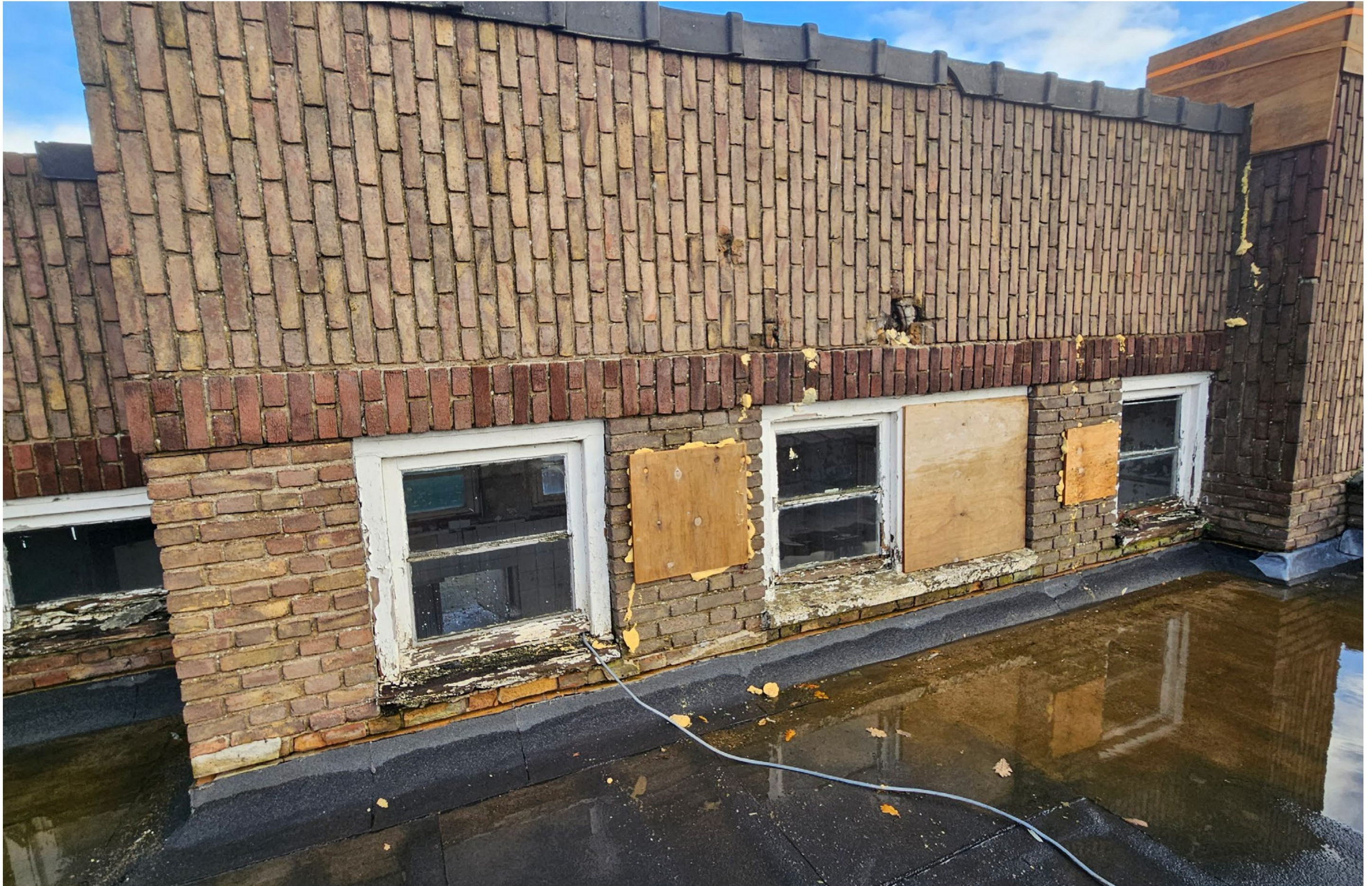
Geveldeel zuidwest gevel tpv. lage dakvloer. Veel aangetast houtwerk in kozijn- en raamhout. Aangetast ijzerwerk wapening betonconstructie in gevelmetselwerk, gaten in gevel (dichtgezet met multiplex) ivm. verwijderd aangetast ijzerwerk.
