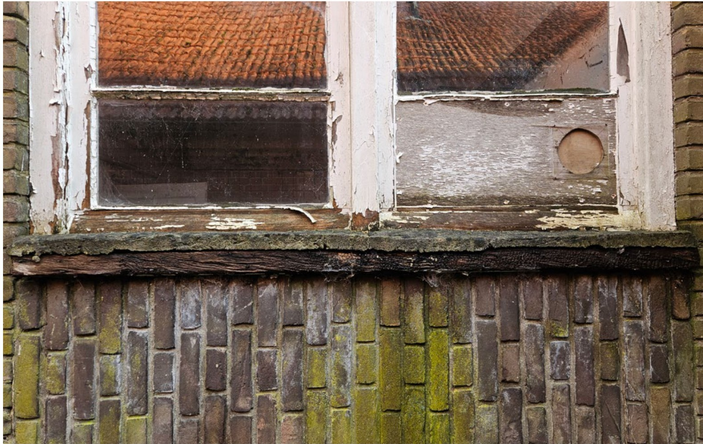
Een laag met mortel/specie is aangebracht over een aangetaste onderdorpel van een kozijn aan de noordwest gevel.
