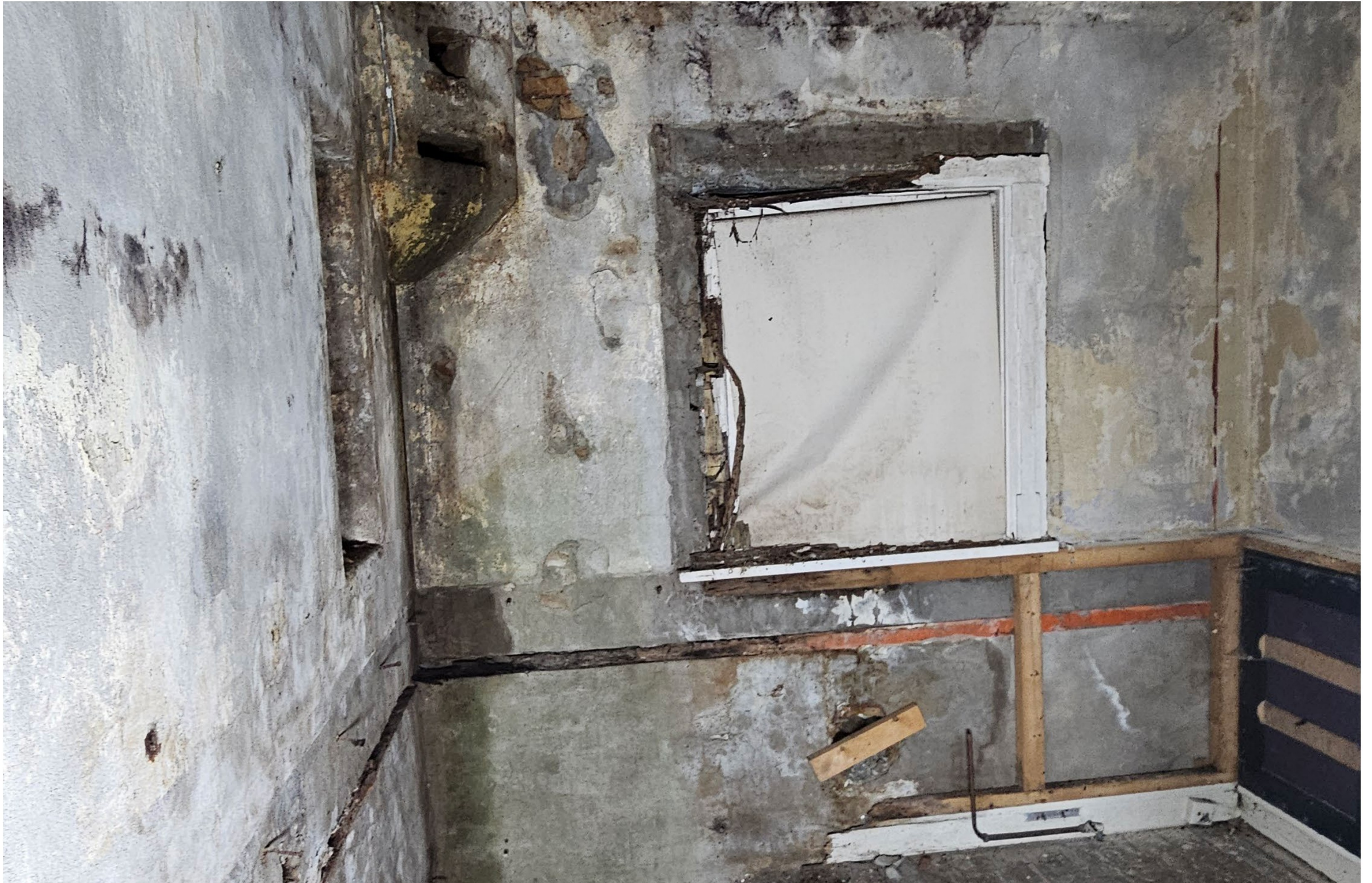
Zuidoost gevel binnenzijde (kantoor). Originele houtwerk betimmering (lambrisering) en betimmering/lijstwerk rondomraam in kantoor aangetast als gevolg van vochting klimaat en lekkage tpv. ramen. Deel bestaande betimmering is reeds ontmanteld en opgeslagen, overige betimmering is nog niet ontmanteld.
