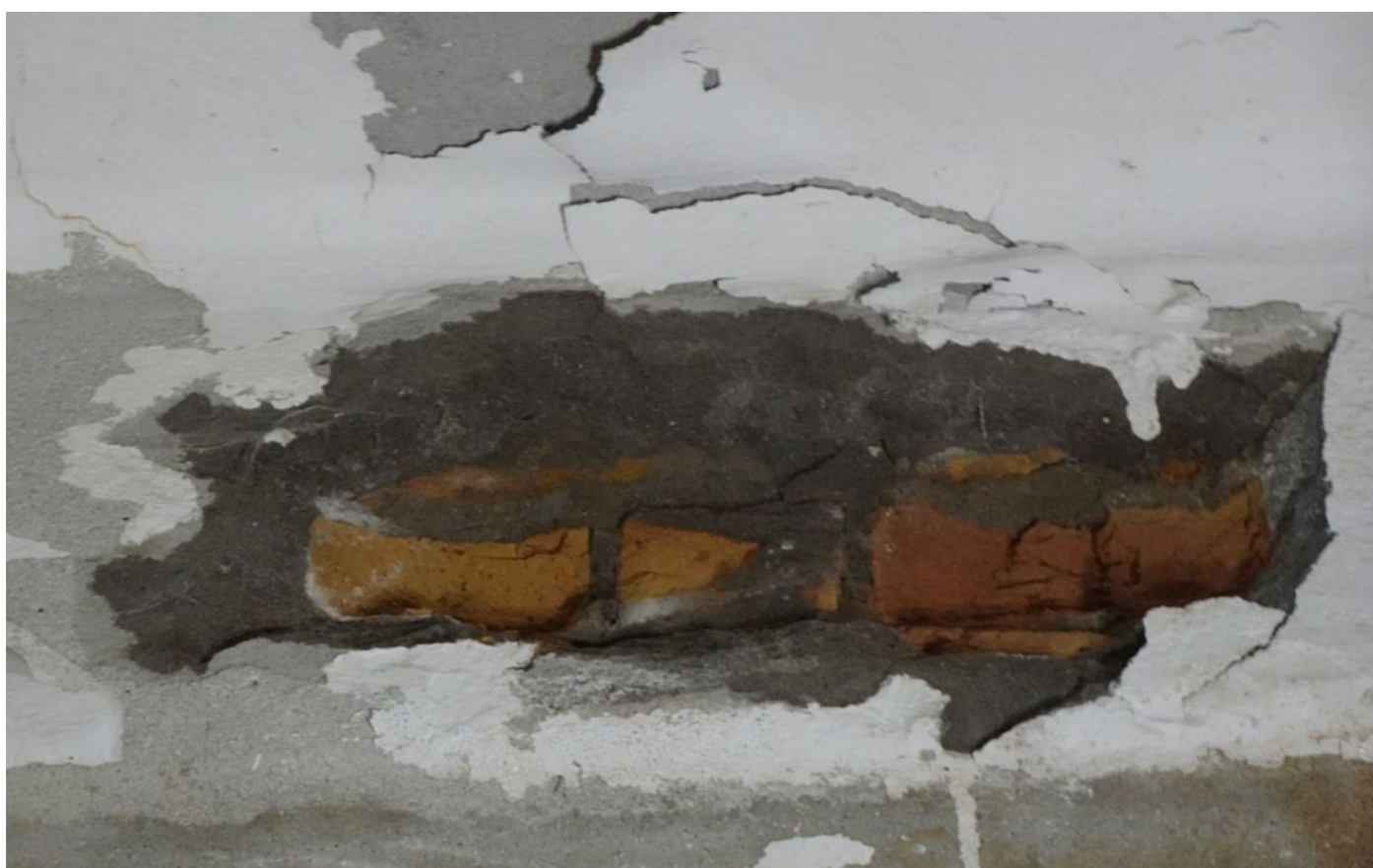
Betonwerk randbalk knapt kapot door harde portlandcement. Achterliggend metselwerk brokkelt af omdat door de toegepaste (te harde) voegen en betonwerk het vocht niet kan worden afgevoerd.
