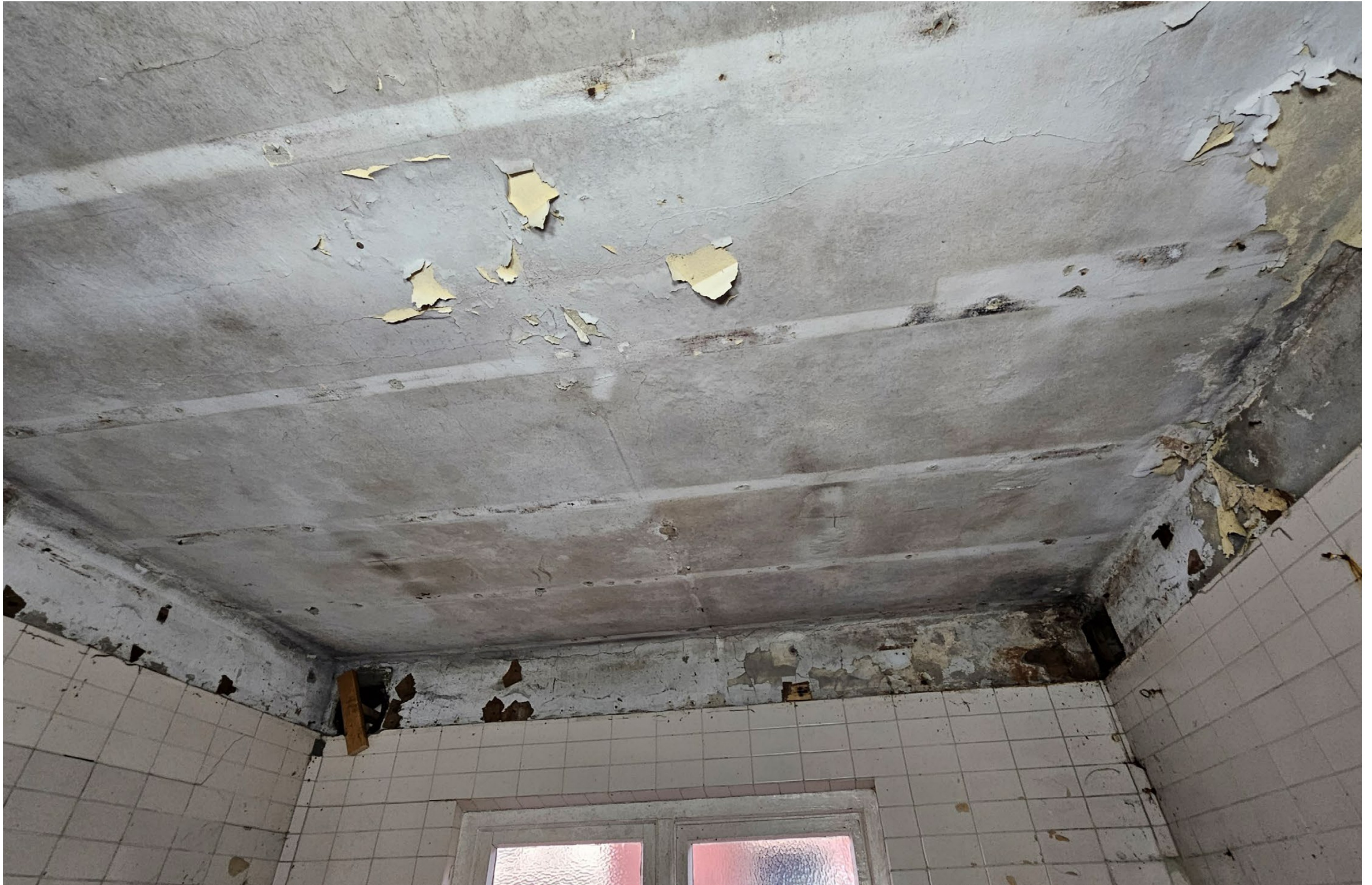
Plafond (uitbeenruimte) met scheurvorming door aangetaste wapening betonnen dakvloer.
