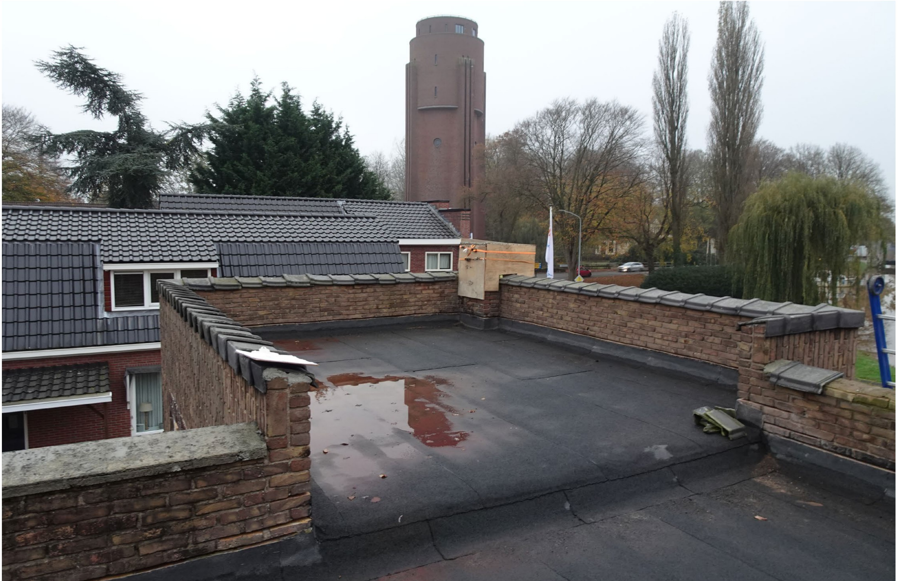
Bitumen dakbedekking en loodslabben hoge dakvloer is reeds vervangen, werkzaamheden loodwerk dient nog te worden aangeklopt. Op diverse plaatsen ontbreken er keramieken afdekkers of zijn deze gebroken. Daarnaast liggen veel afdekkers liggen los, omdat de mortellaag los is gekomen aan de onderzijde.
