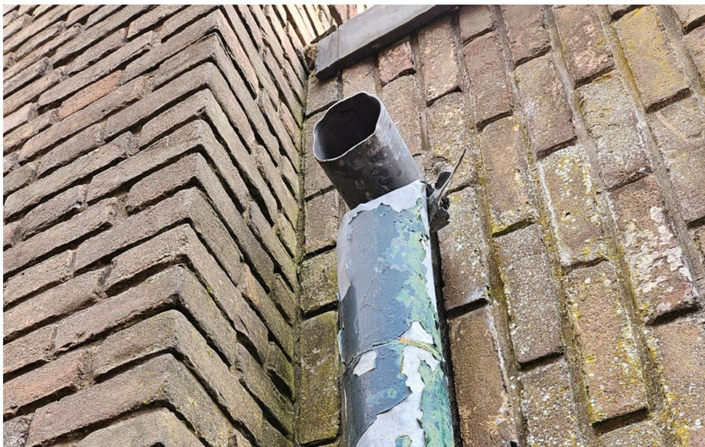
Hemelwaterafvoeren zijn niet aangesloten op de doorvoeren. Bij regenval stromen deze over op het maaiveld waardoor er verzakkingen ontstaan.
