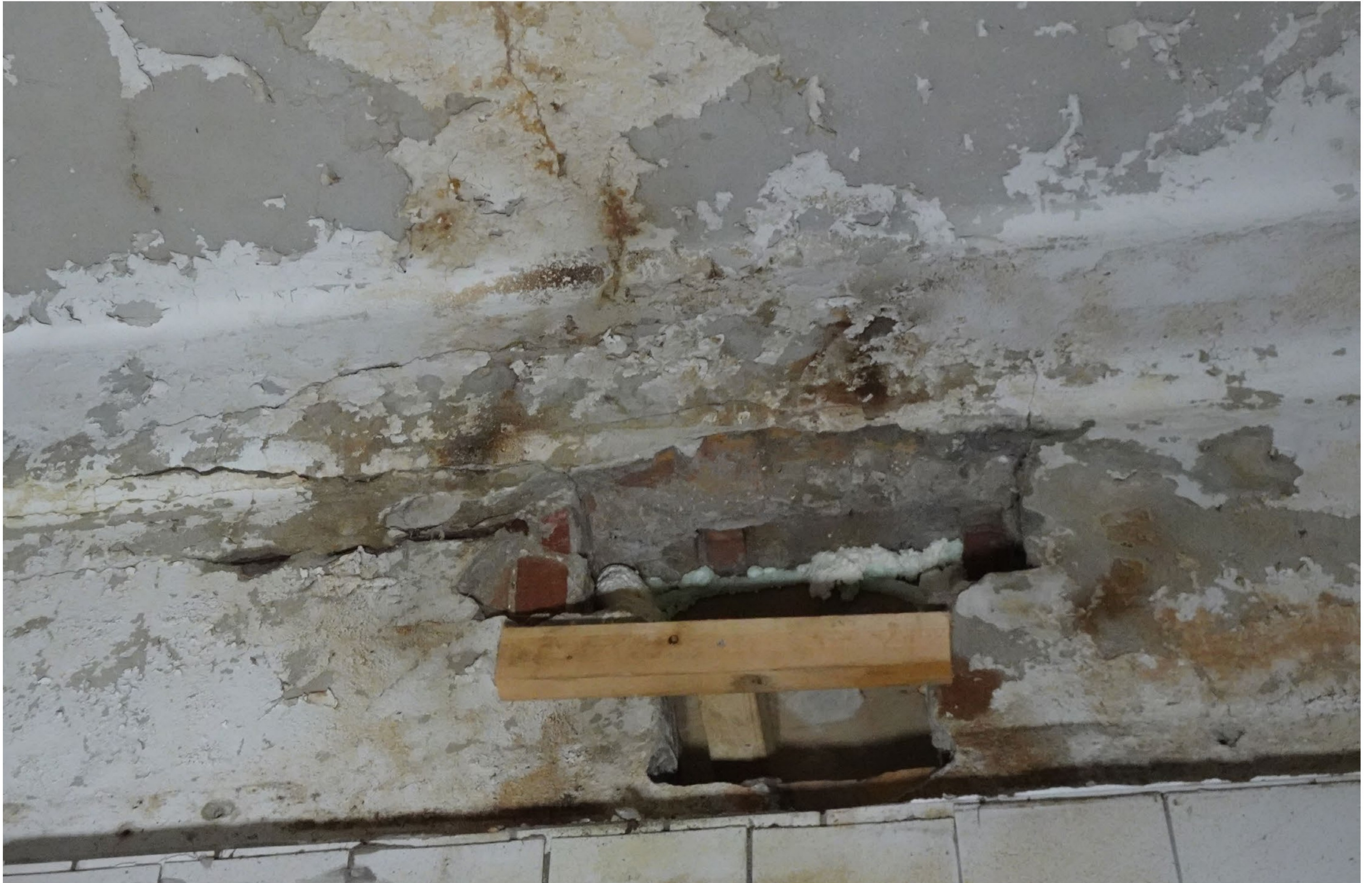
Gat in metselwerk gevel als gevolg van (reeds verwijderd) aangetast ijzerwerk staalconstructie. Betonwerk randbalk knapt kapot door harde portlandcement.
