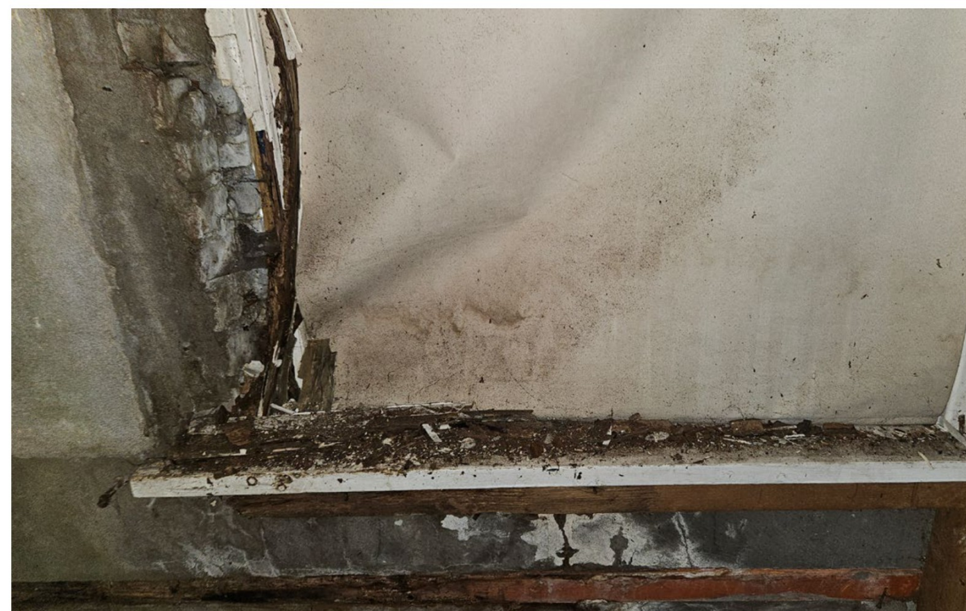
Aangetast houtwerk raamkozijn en lijstwerk.
