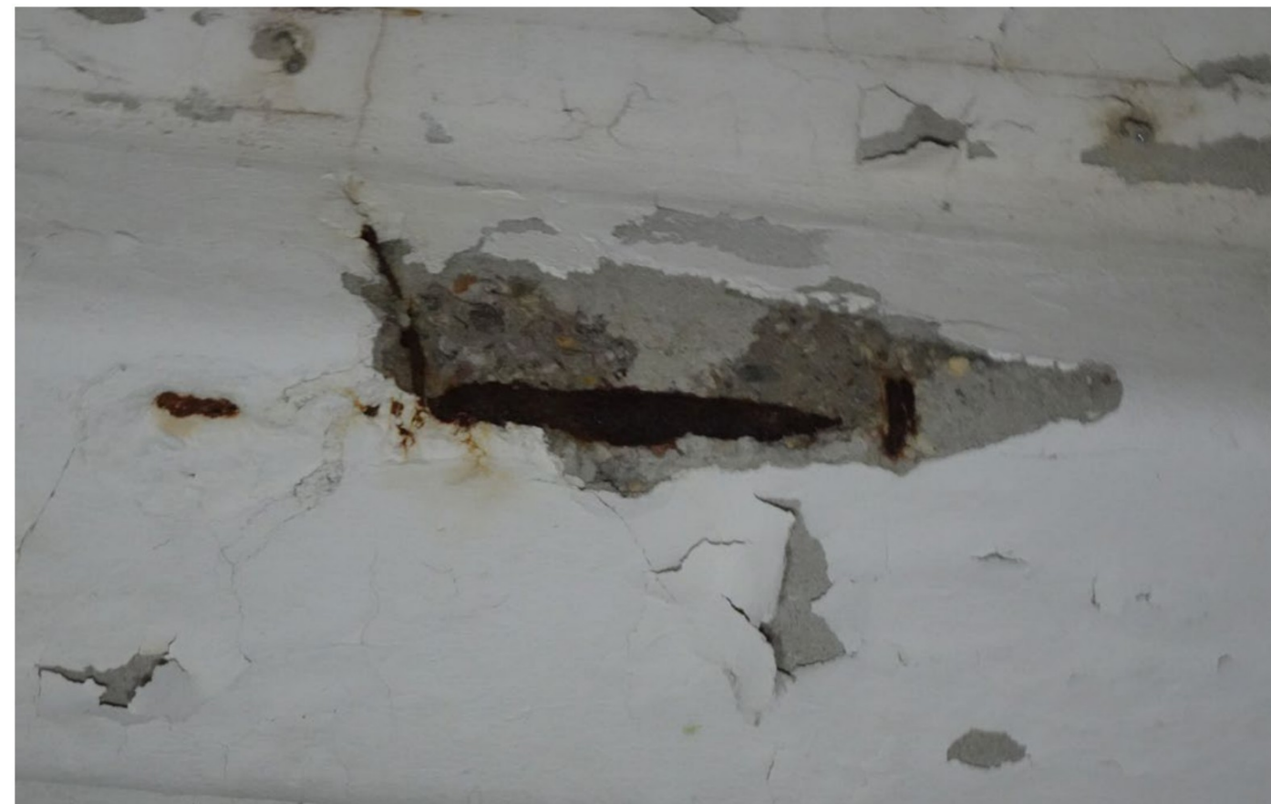
Betonwerk balkenkruis dakvloer knapt kapot door aangetaste wapening.
