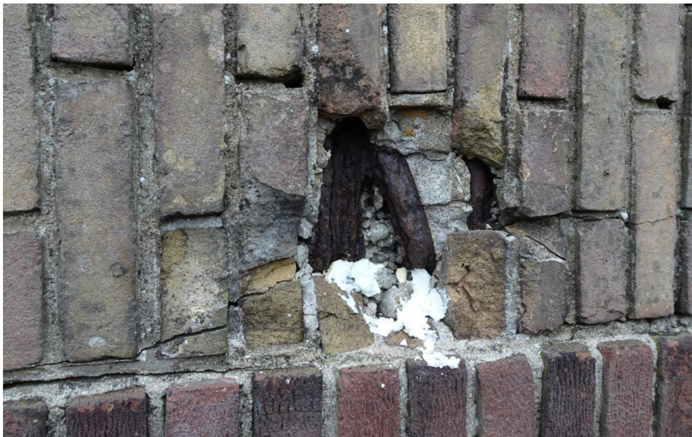
Metselwerk knapt kapot door aangetaste wapening van balkenkruis hoge dakvloer.
