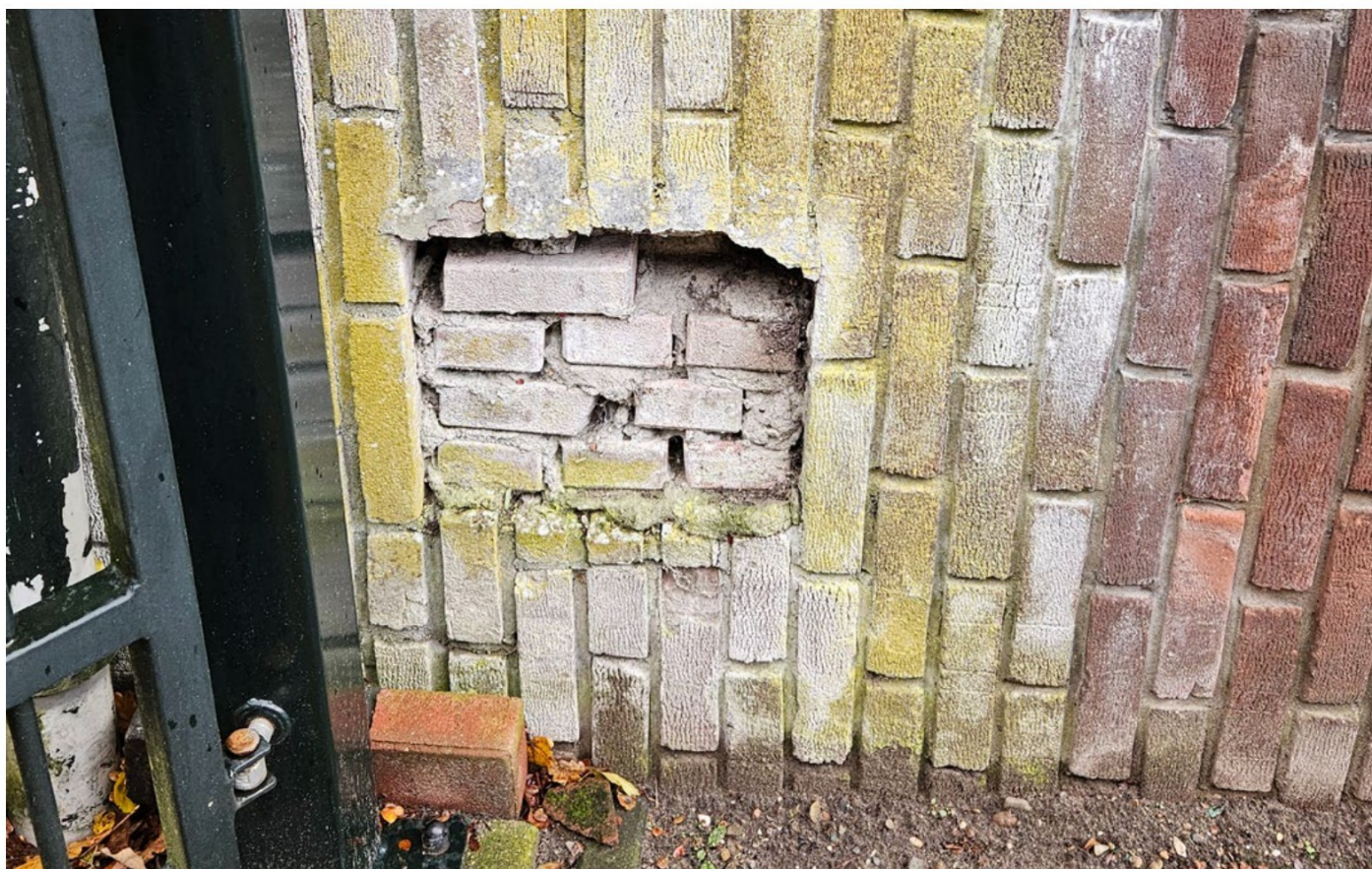
Ondeskundig uitgevoerd inboetwerk, witte uitslag op metselwerk door een overstromende hemelwaterafvoer.
