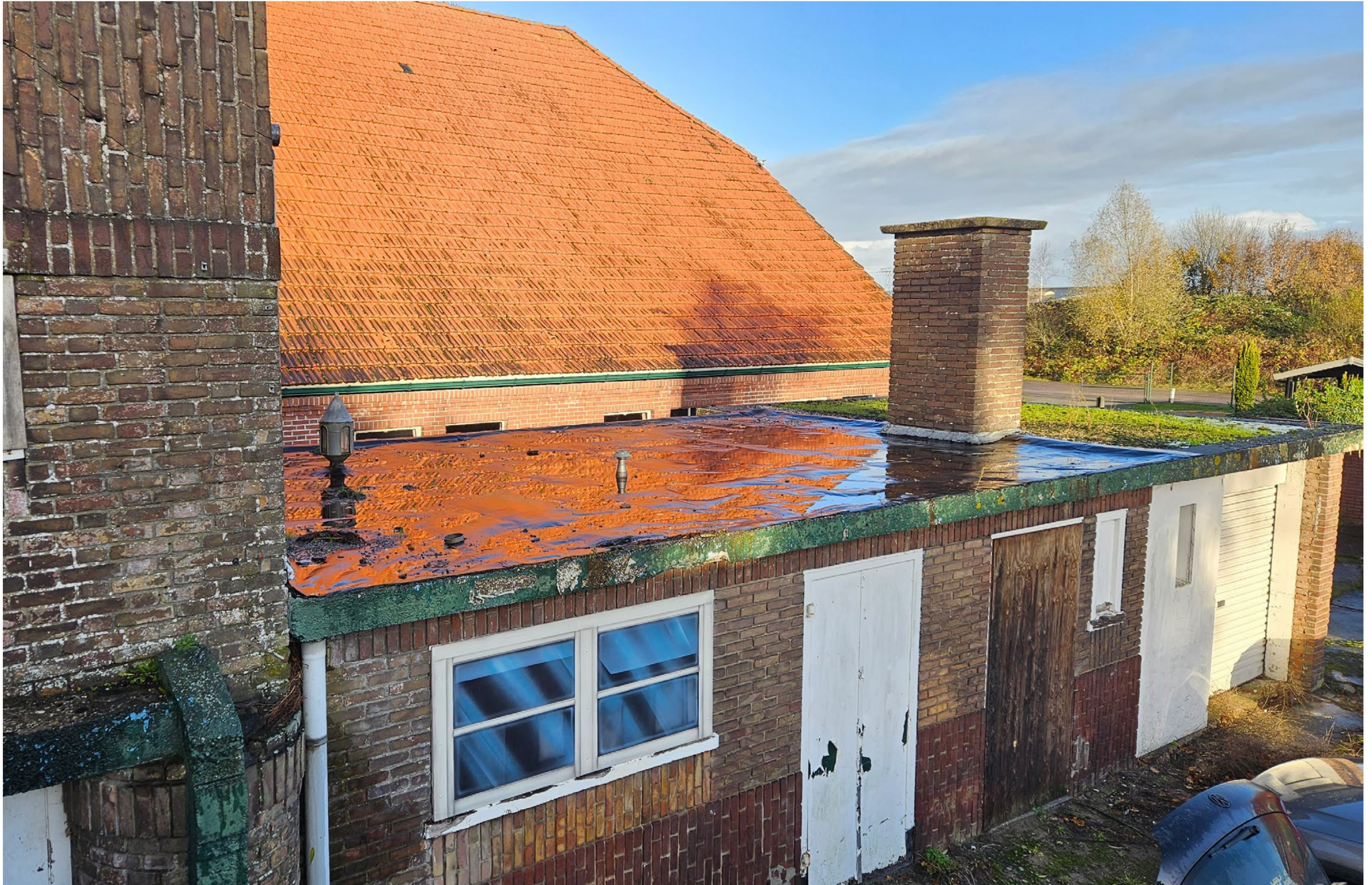
Dakvloer lage aanbouw aan achterzijde (noordzijde), Bitumen dakbedekking bevat veel blaasvorming door vocht wat onder toplaag dakbedekking zit. Dakbedekking is aangebracht over oude dakbedekking, hier is nog veel gruis aanwezig van ballast of mastiek.
