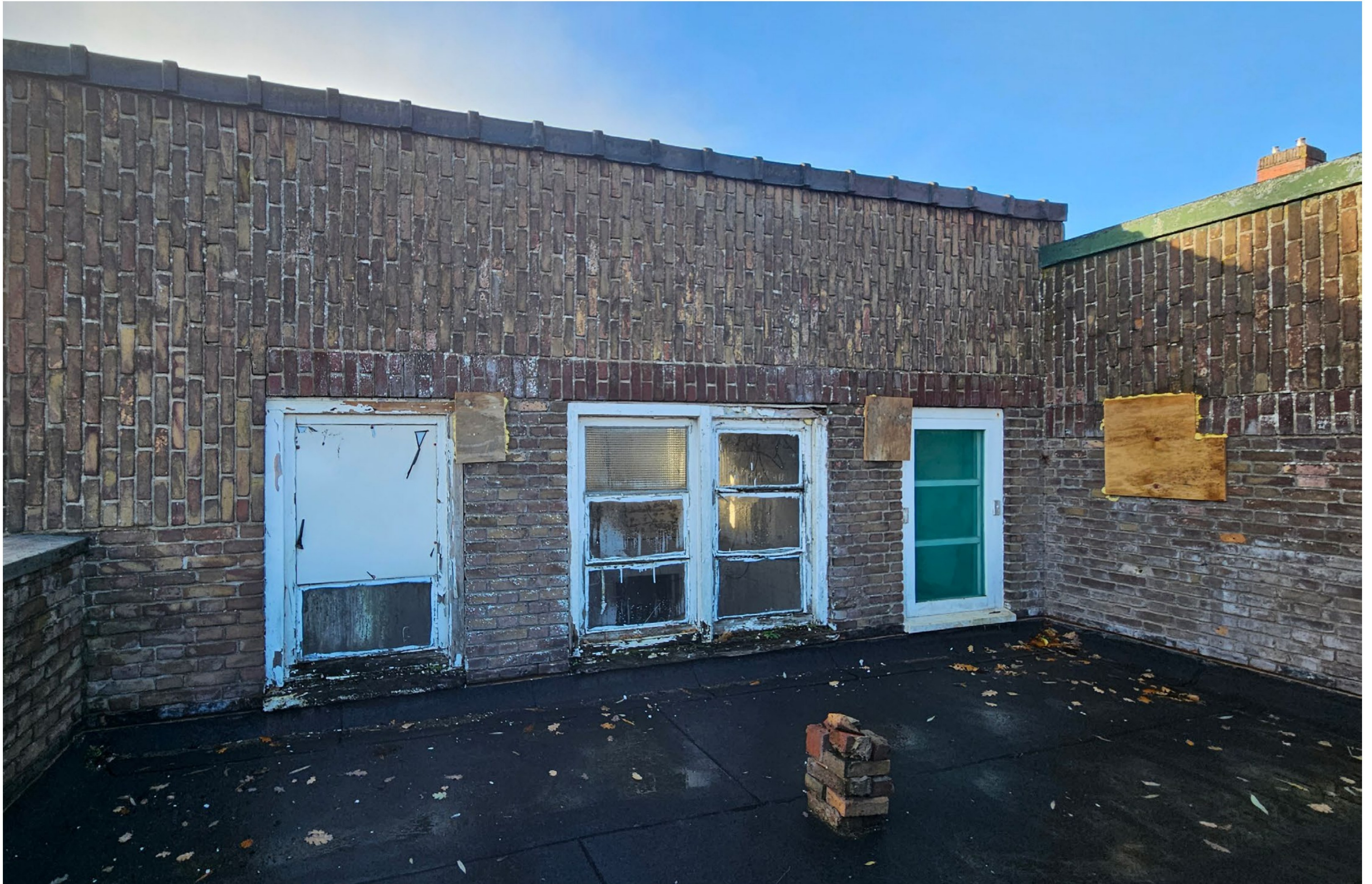
Geveldeel noordoost gevel tpv. lage dakvloer. Veel aangetast houtwerk in kozijn- en raamhout. Aangetast ijzerwerk wapening betonconstructie in gevelmetselwerk, gaten in gevel (dichtgezet met multiplex) ivm. verwijderd aangetast ijzerwerk.
