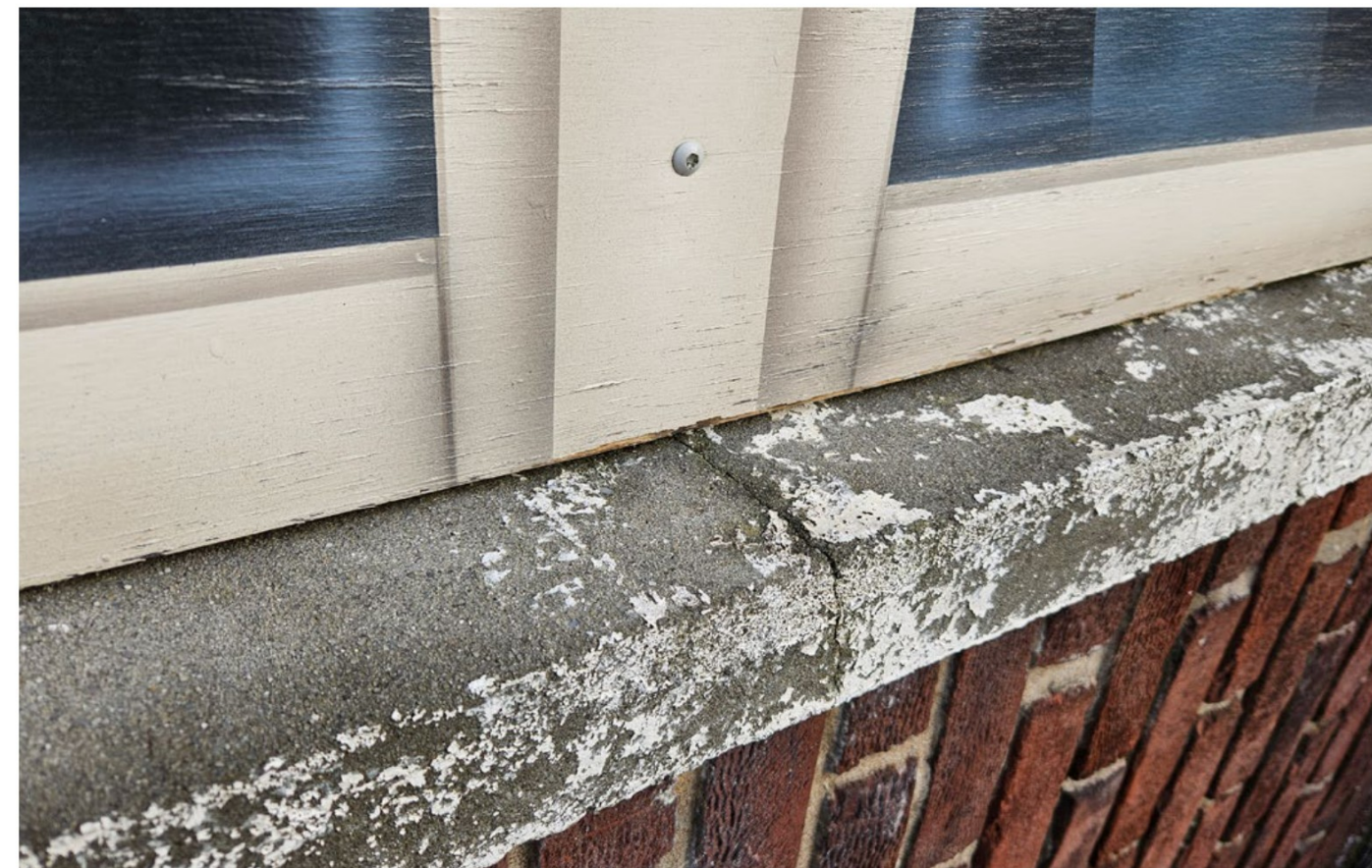
In het verleden zijn op een aantal plaatsen betonnen onderdorpels tpv. kozijnen aangebracht.
