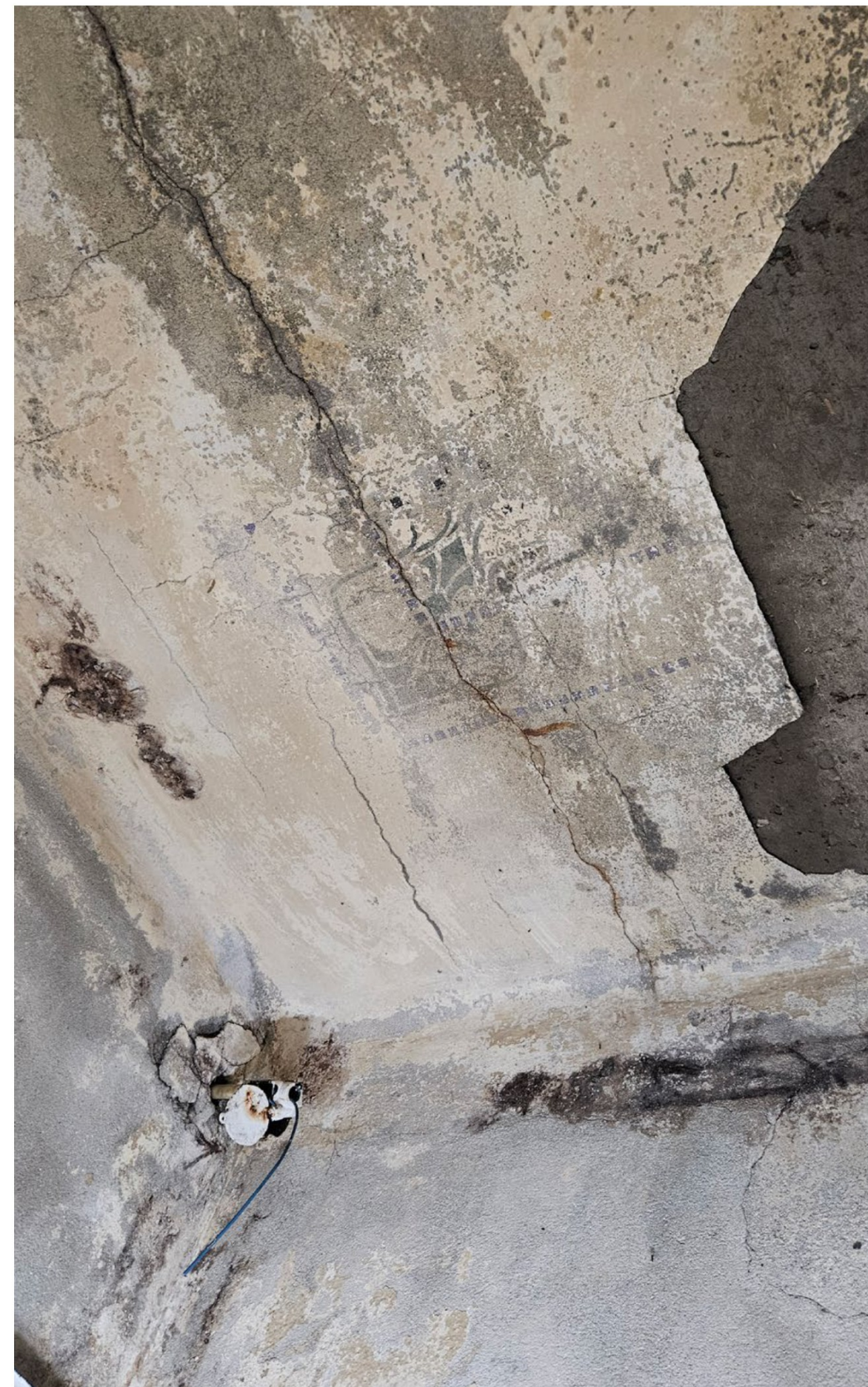
Originele sjabloon (2/4) en gestippelde kader, op de foto is duidelijk dat scheurvorming ontstaan door aangetaste wapening in betonnen dakvloer. Daarnaast is zichtbaar dat de pleisterlaag loslaat.
