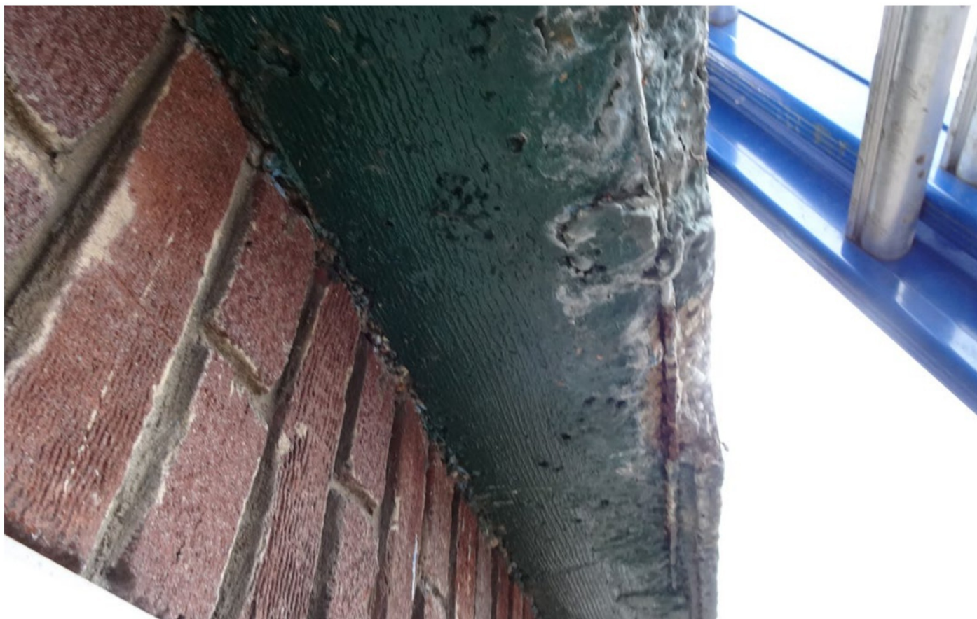
Betonrot in dakvloer lage aanbouw noordzijde. Wapening betonvloer ligt dicht aan de oppervlakte, in combinatie met de grove betonafwerking is deze gevoelig voor aantasting.
