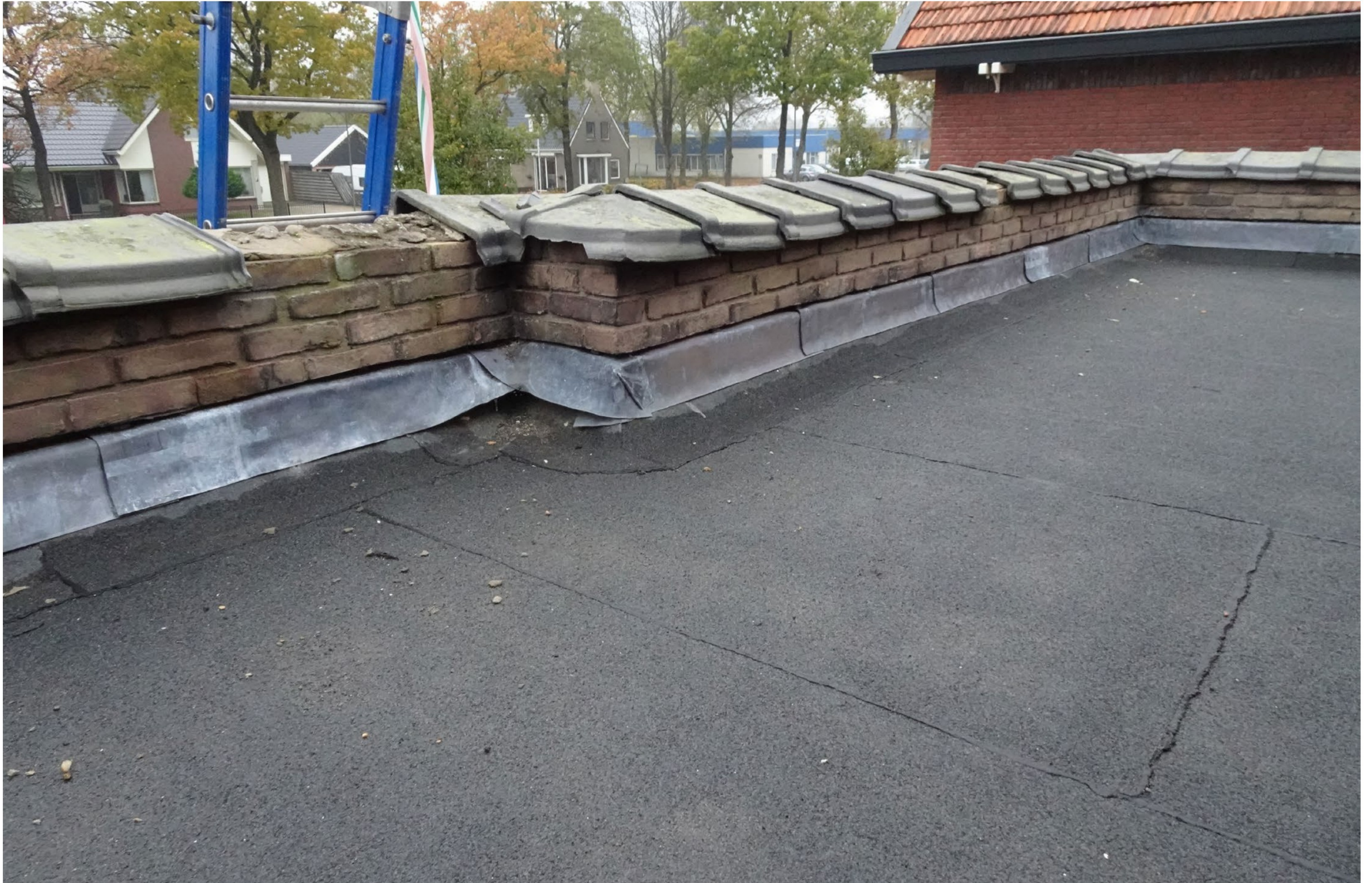
Bitumen dakbedekking en loodslabben lage dakvloer zuidzijde is reeds vervangen, werkzaamheden loodwerk dient nog te worden aangeklopt. Op diverse plaatsen ontbreken er keramieken afdekkers of zijn deze gebroken. Daarnaast liggen veel afdekkers liggen los, omdat de mortellaag los is gekomen aan de onderzijde.
