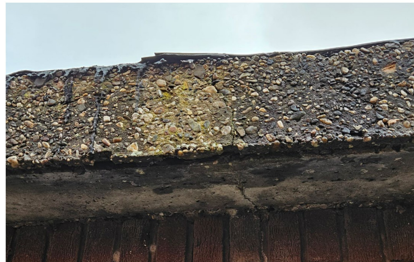
Scheurvorming in betonnen dakvloer tpv. noordwest gevel.
