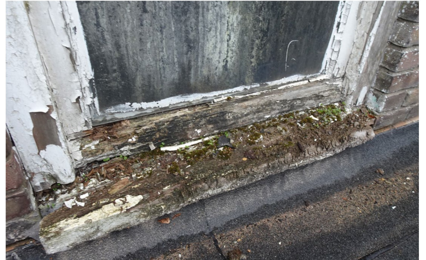
Bij diverse kozijnen zijn de liggende delen (dorpels ed.) aangetast door houtrot. Uitgaande van dat ca. 75% van al het liggend werk is aangetast.
