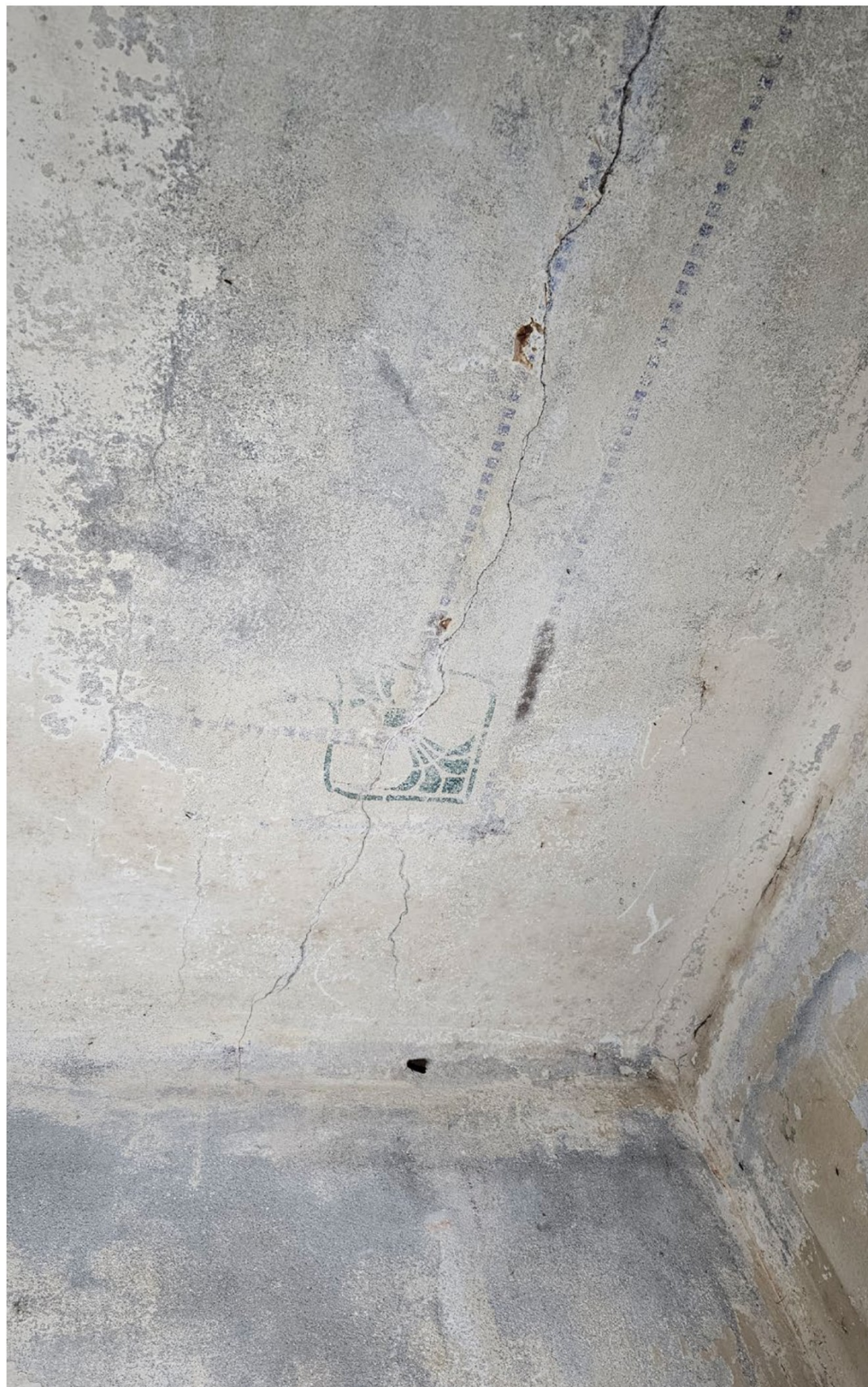
Originele sjabloon (1/4) en gestippelde kader, op de foto is duidelijk dat scheurvorming ontstaan door aangetaste wapening in betonnen dakvloer.
