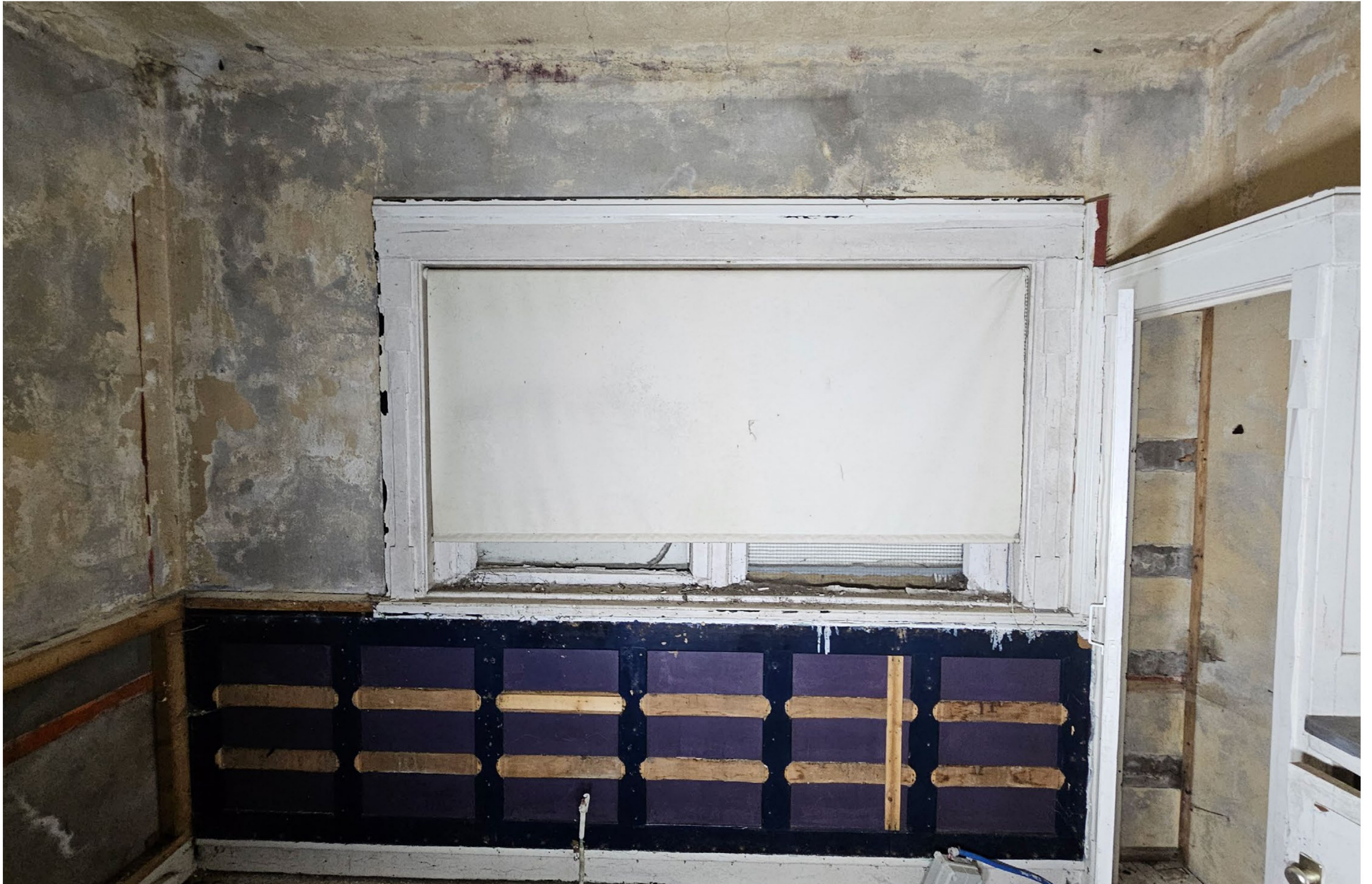
Zuidwest gevel binnenzijde (kantoor). Originele houtwerk betimmering (lambrisering) en betimmering/lijstwerk rondomraam in kantoor aangetast als gevolg van vochting klimaat en lekkage tpv. ramen. Deel bestaande betimmering is reeds ontmanteld en opgeslagen, overige betimmering is nog niet ontmanteld.
