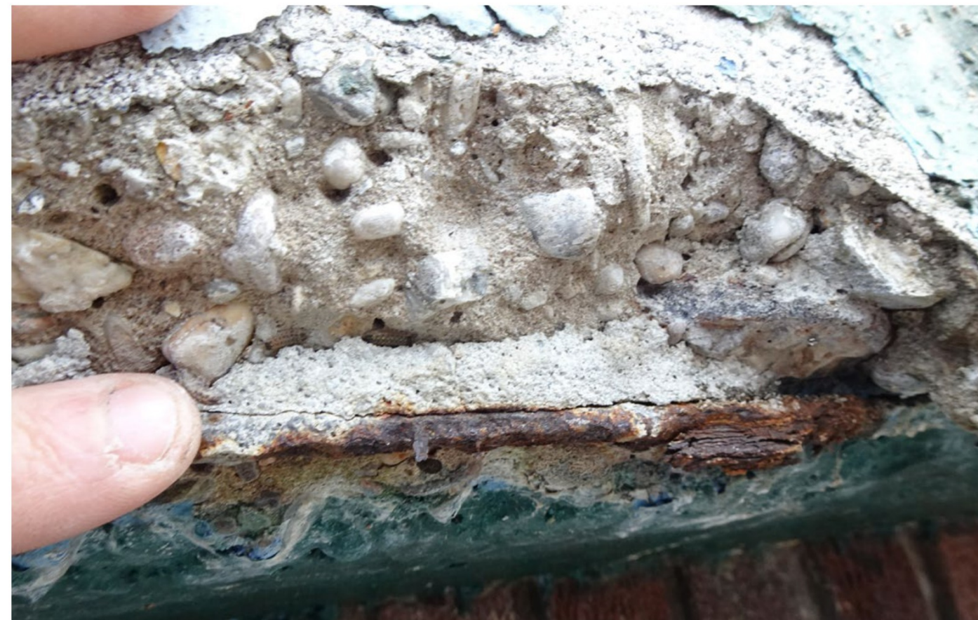
Betonrot in dakvloer lage aanbouw noordzijde.
