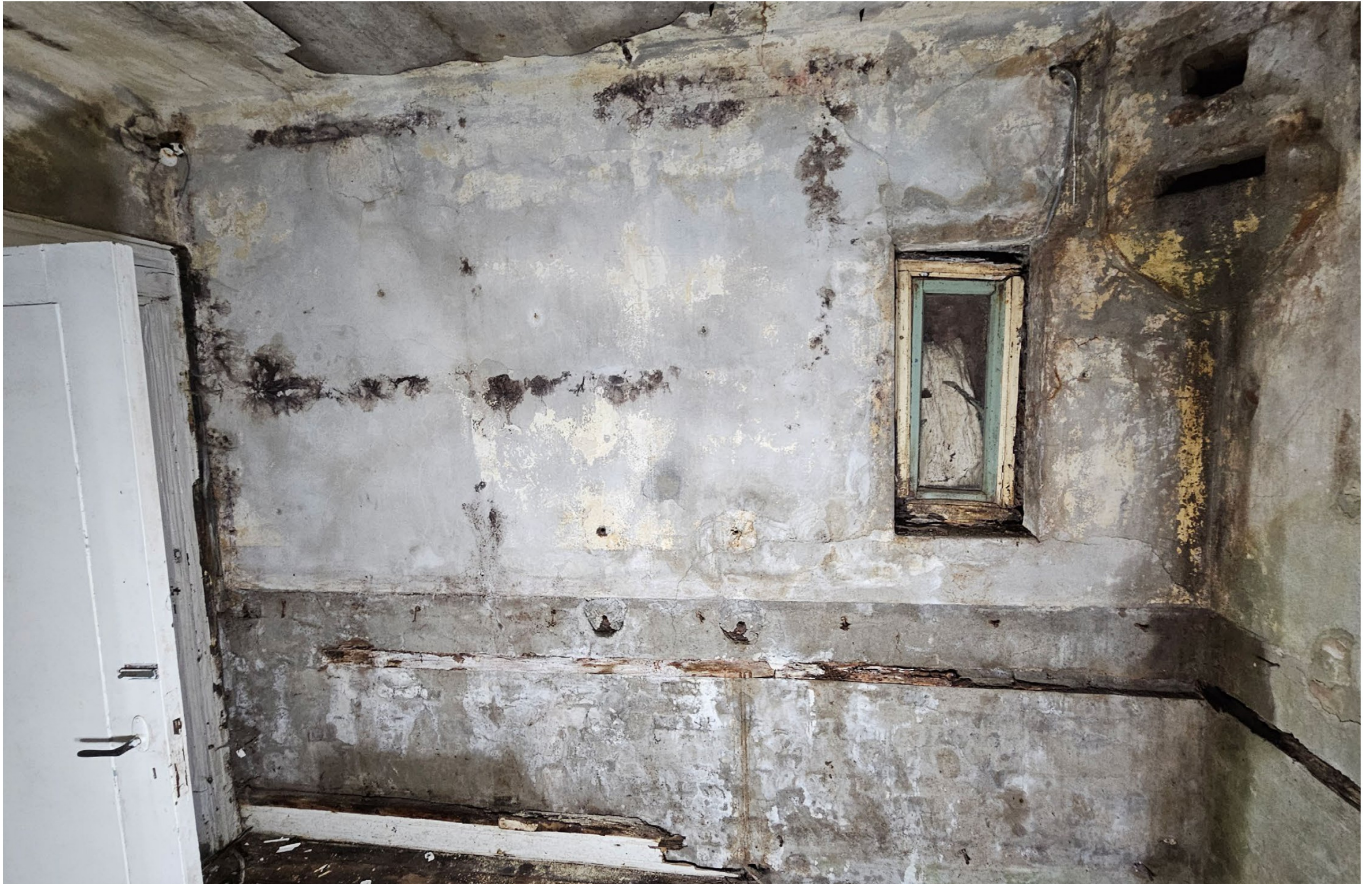
Noordoost gevel binnenzijde (kantoor). Originele houtwerk betimmering (lambrisering) en betimmering/lijstwerk rondom deur(en) in kantoor aangetast als gevolg van vochtig klimaat en lekkage tpv. ramen. Deel bestaande betimmering is reeds ontmanteld en opgeslagen, overige betimmering is nog niet ontmanteld.
