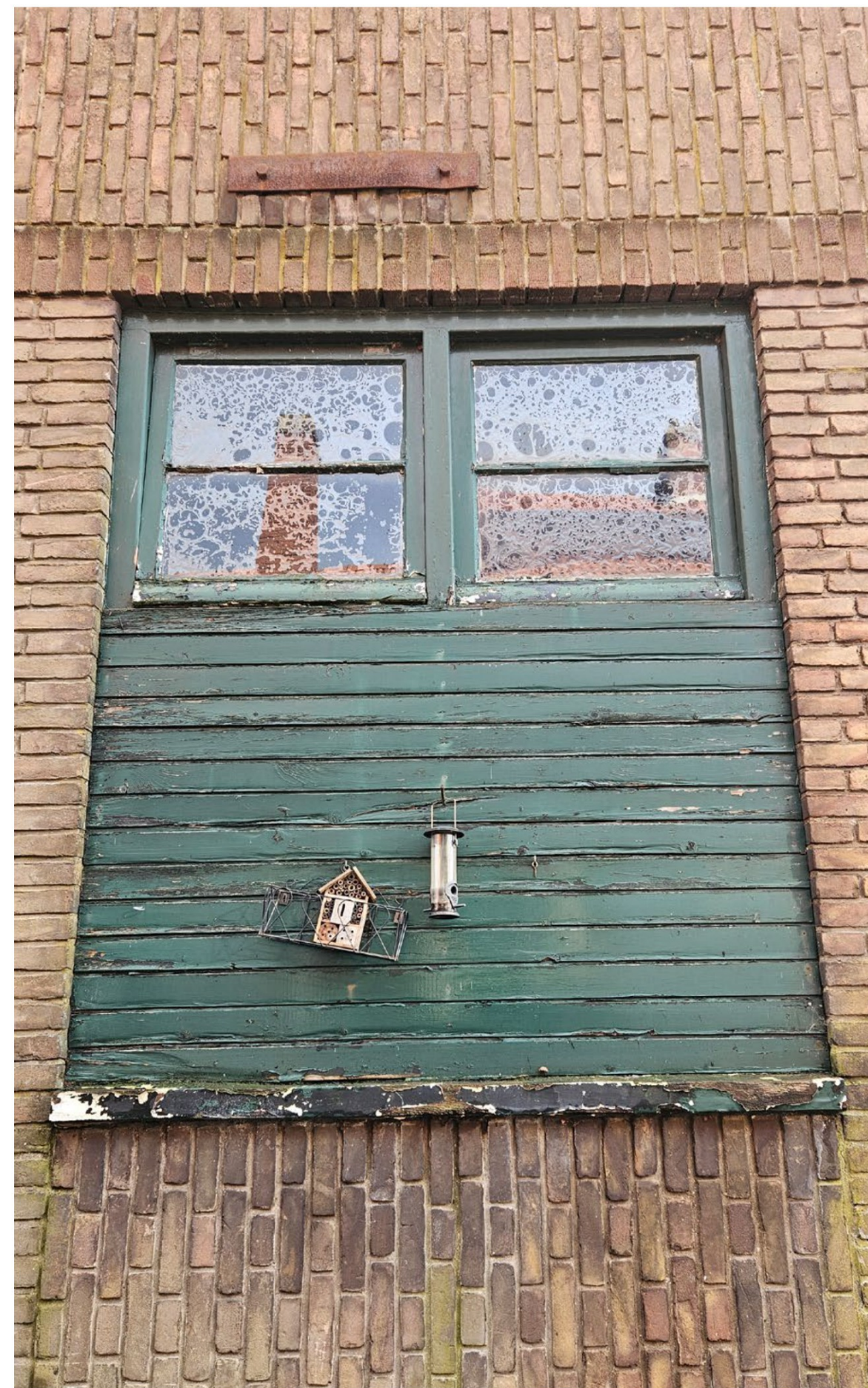
Originele raam tpv. noordwest gevel, dichtgetimmerd met schroten. Mogelijk aangetast houtwerk in kozijn- en raamhout aanwezig.
