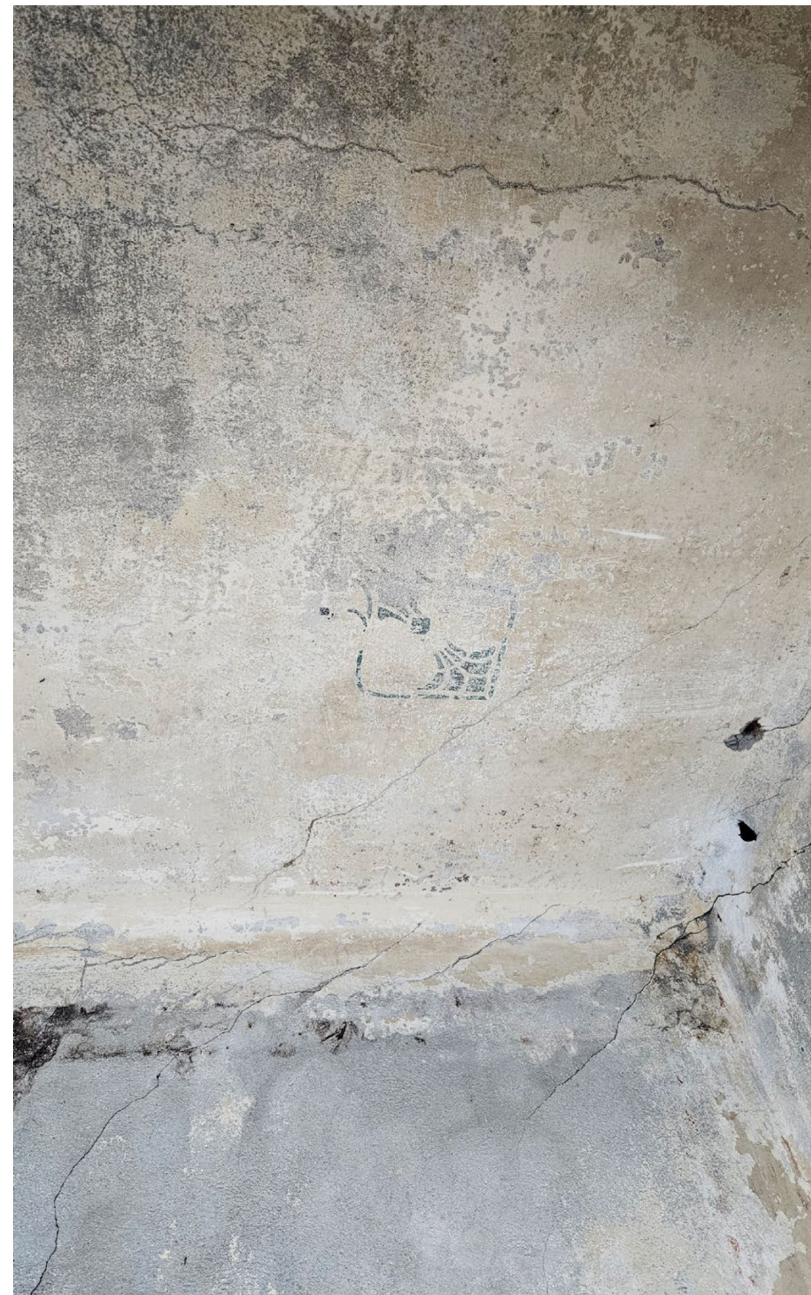
Originele sjabloon (4/4) en gestippelde kader, op de foto is duidelijk dat scheurvorming ontstaan door aangetaste wapening in betonnen dakvloer.
