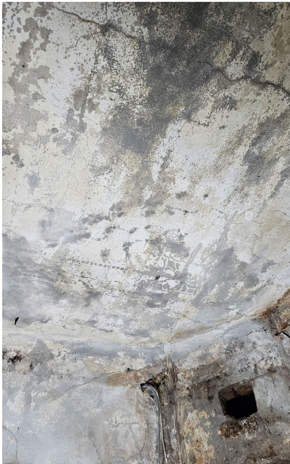
Originele sjabloon (3/4) en gestippelde kader, op de foto is duidelijk dat scheurvorming ontstaan door aangetaste wapening in betonnen dakvloer.
