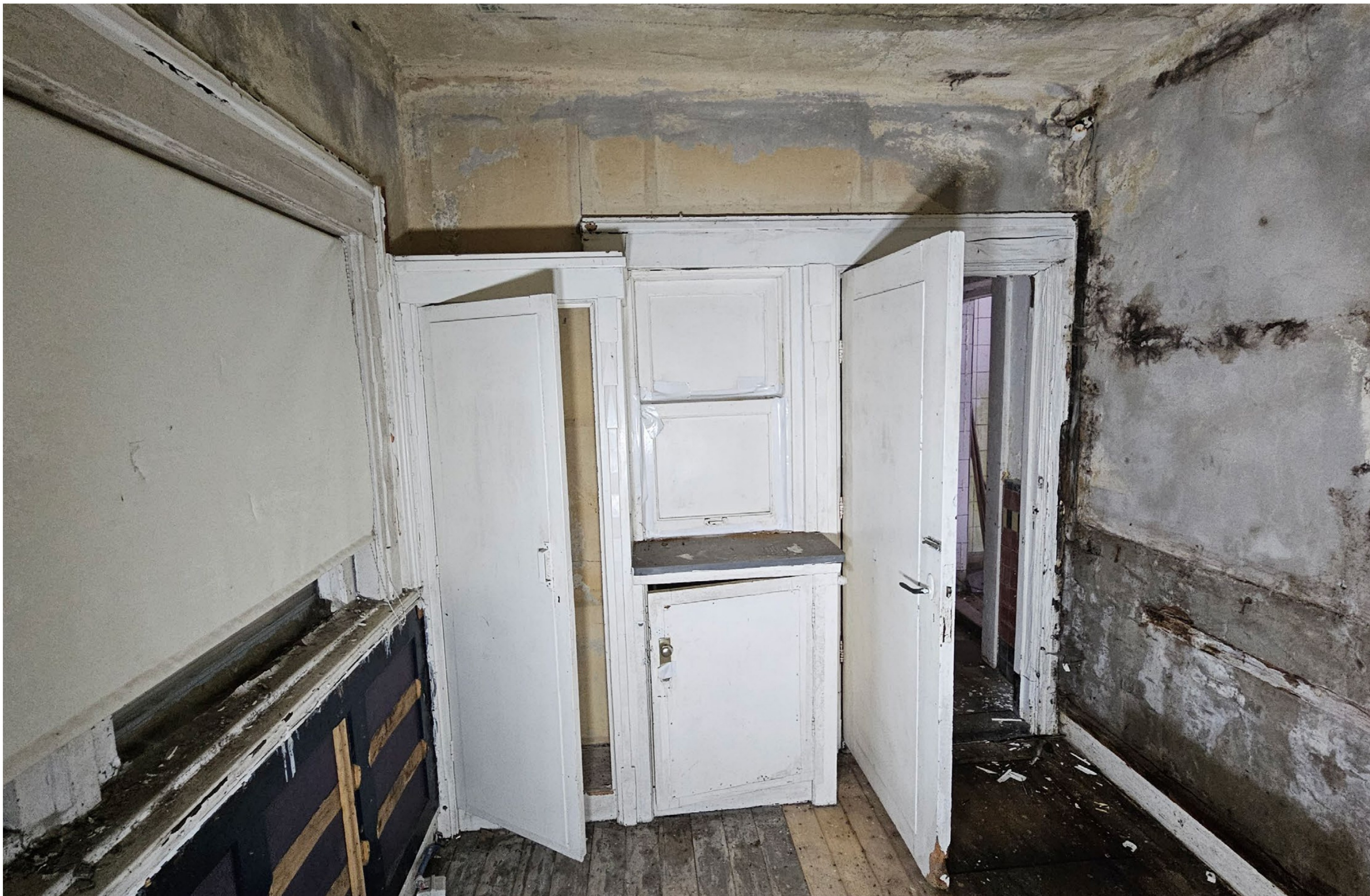
Noordwest gevel binnenzijde (kantoor). Originele houtwerk betimmering (lambrisering) en betimmering/lijstwerk rondom deur(en) in kantoor aangetast als gevolg van vochtig klimaat en lekkage tpv. ramen. Deel bestaande betimmering is reeds ontmanteld en opgeslagen, overige betimmering is nog niet ontmanteld.
