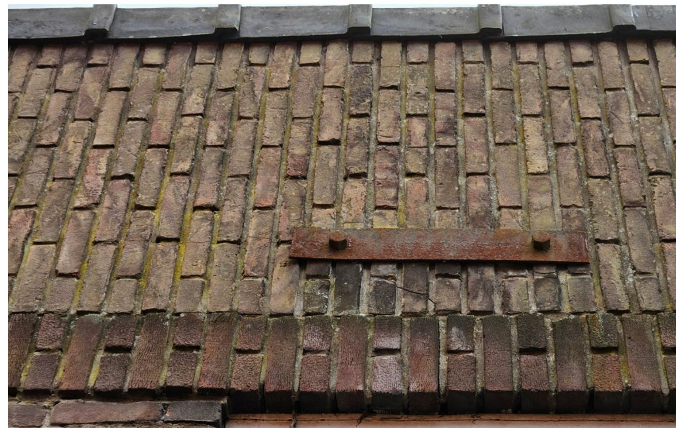
Aangetaste ankers tbv. ijzerconstructie(s) aan binnenzijde.
