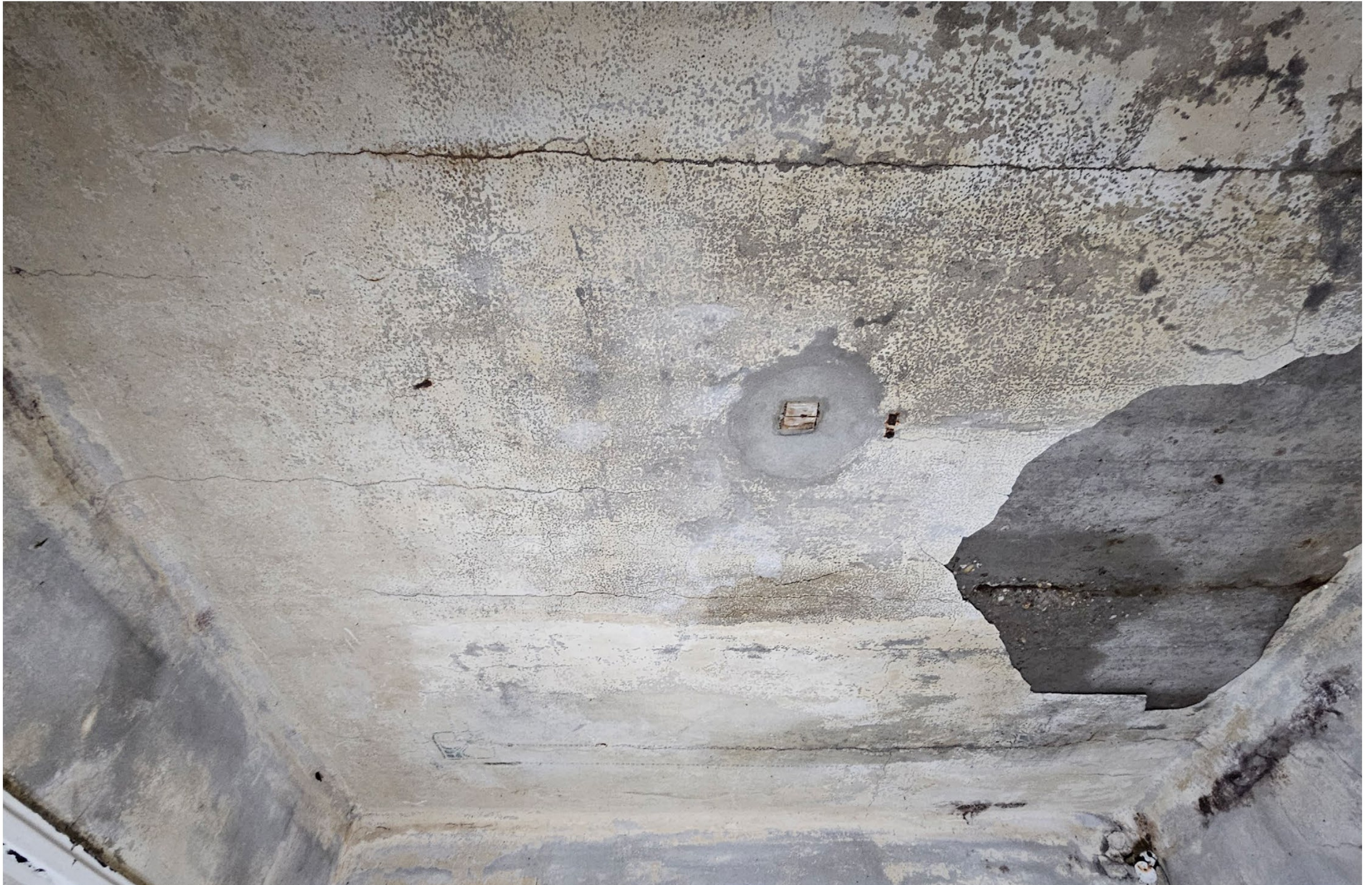
Plafond kantoor met schilderwerk sjablonen in hoeken en gestippelde kader. Wapening betonnen dakvloer is aangetast door vochtig klimaat en lekkages. Hierdoor ontstaat er scheurvorming in het pleisterwerk met daarop schilderwerk, pleisterwerk laat op veel plaatsen los door vochtigheid.
