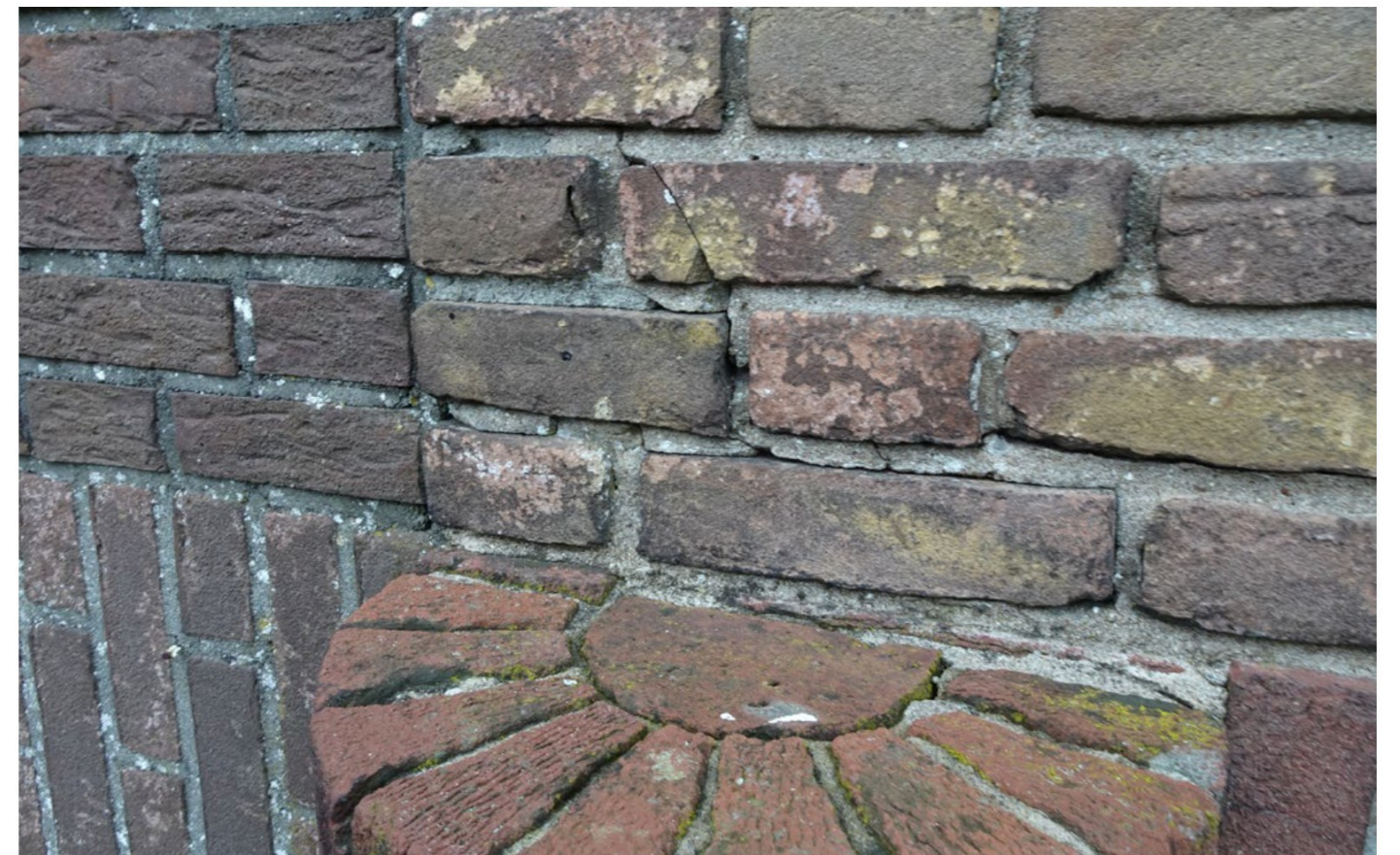
Bij diverse gevels is er scheurvorming en uitgesleten voegwerk aanwezig. De voeg bestaat uit een harde cementvoeg die snel kapot knapt.
