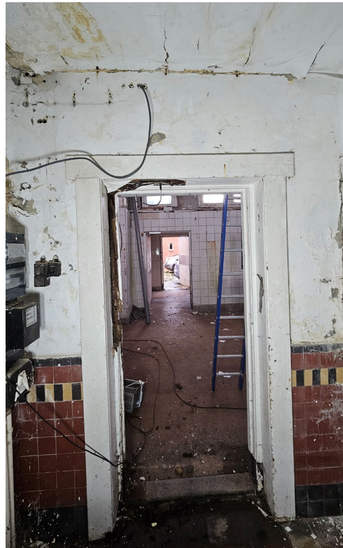
Oorspronkelijke entree met tegelvloer en lambrisering met tegelwerk. Aangetast houtwerk kozijn en omtimmering door hoge luchtvochtigheid en lekkages.
