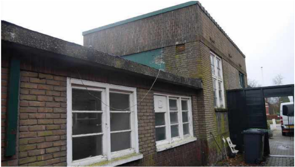
Twee liggende vensters met horizontale roedeverdeling in de zijvleugel: een dubbel en een driedubbel venster
