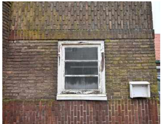
Staan drieruitvenster met een horizontale roedeverdeling
