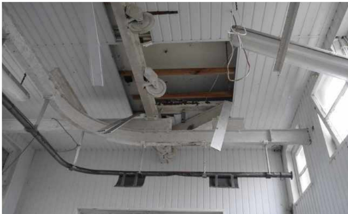
Plafond van de slachthal met het metalen transportsysteem. De ramen aan de bovenkant voorzien de ruimte van daglicht
