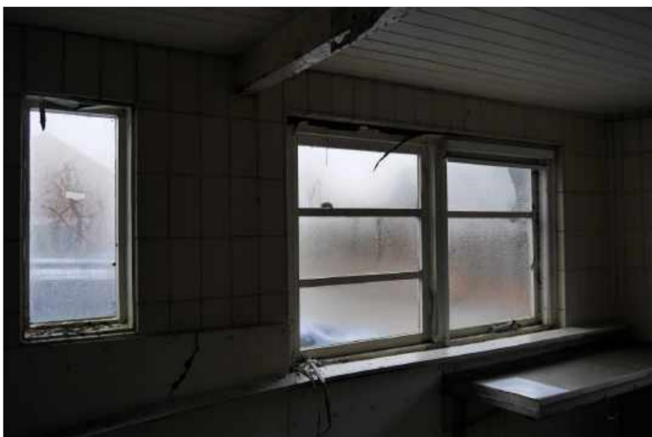
Smal verticaal venster zonder roedeverdeling en dubbel venster, waarvan het linkerdeel nog de originele horizontale roedeverdeling heeft en het rechterdeel is vervangen voor een naar buiten openend klampaam met draadglas
