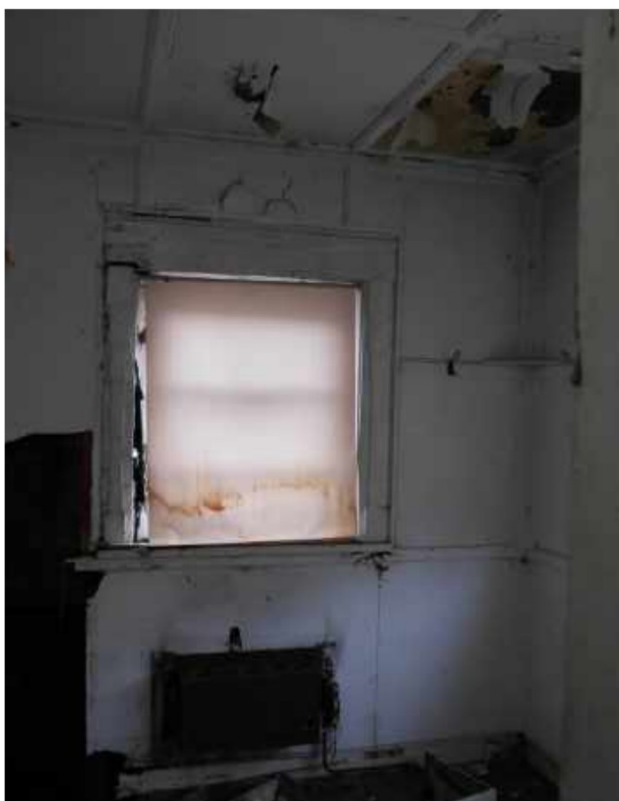
Geprofileerde houten stijlen en regels op de wanden van het kantoor en 'cassettenplafond' met geprofileerde houten latten
