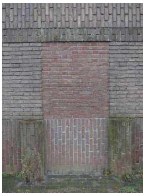
Een van de twee later dichtgemetselde deuropeningen in de voorgevel
