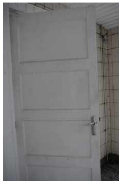
Opslagruimte in de zijvleugel met op de middelste en rechterfoto de deur naar de kantoorruimte. De deur is nog een originele vierpaneelsdeur (Bruynzeel)
