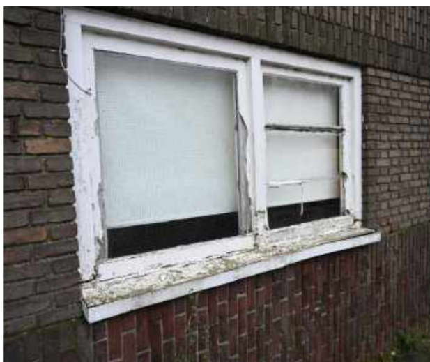
Dubbel venster waarvan alleen het rechterraam nog de oorspronkelijke horizontale roedeverdeling heeft.
