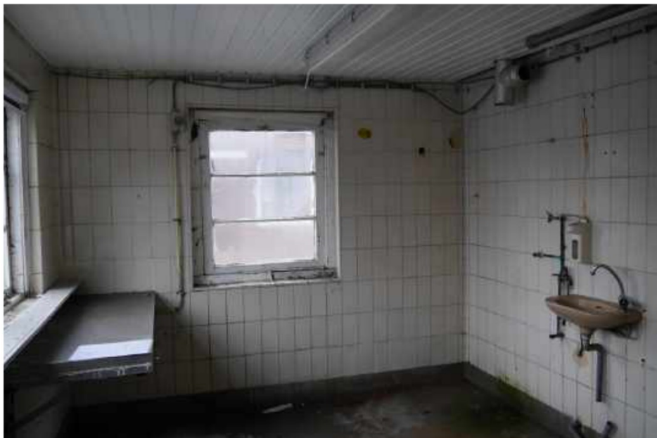
Staan drieruitvenster met horizontale roedeverdeling aan de zuidoostzijde. De ruimte is voorzien van betegelde wanden en een schrootjesplafind
