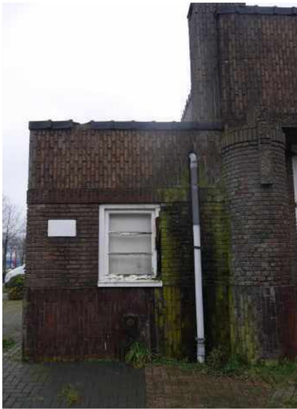
Muurpijler met verticale decoratieve band van grindbeton. Links van het hogere bouwvolume het lagere bouwdeel met staand drieruitvenster met een horizontale roedeverdeling
