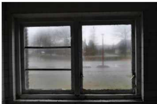
dubbel venster met nog originele horizontale roedeverdeling in het linkerdeel; het rechterdeel is vervangen voor een naar buiten openend klampaam
