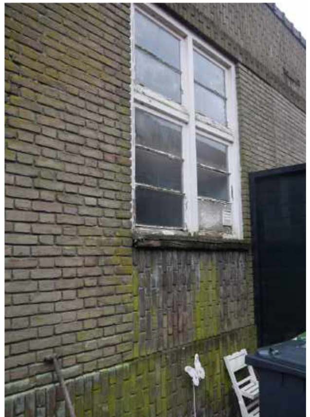
Het derde grote raam in het hogere gedeelte van de noordwestgevel; nog in oorspronkelijke staat
