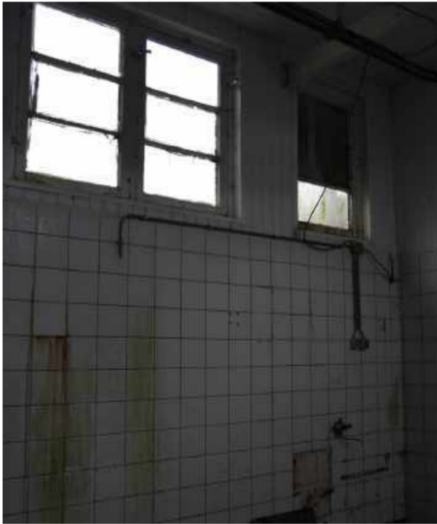
Ramen aan de bovenkant van de slachthal zorgen voor indirecte lichtinval. De wanden zijn voorzien van vierkante witte tegels (waarschijnlijk niet origineel)
