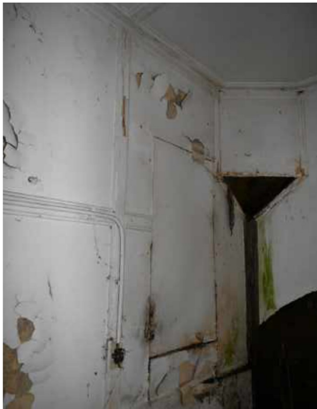
Stookplaats in de hoek van het kantoor; geprofileerde houten stijlen en regels op de wanden
