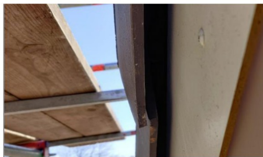
Afbeelding 10. Overhangende kopgevelpan.
