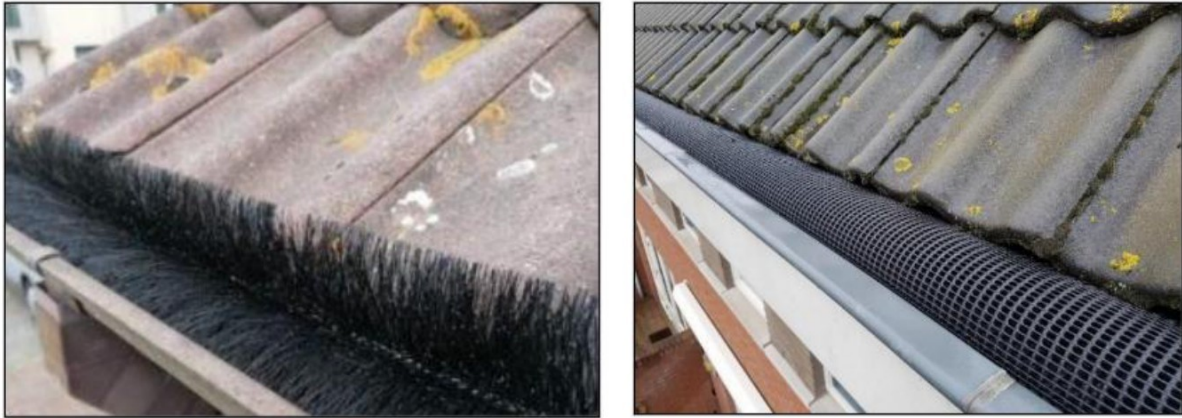
Afbeelding 12. Borstelrollen of gootrollen onder dakpannen.
