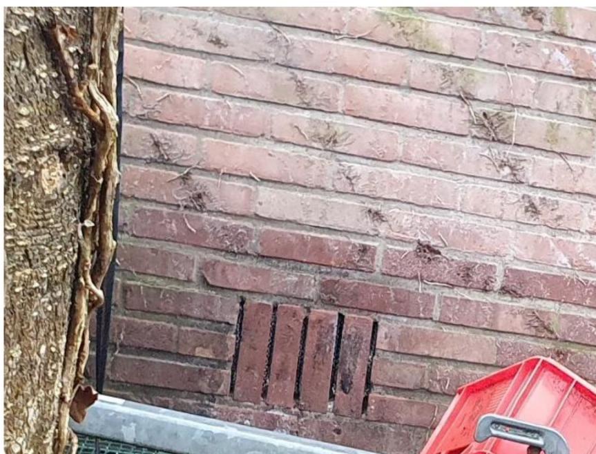
Foto 10: Ventilatievoegen dichtgezet met RVS gaas
