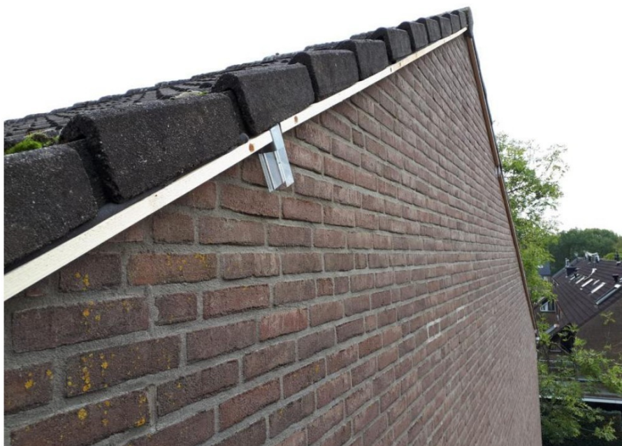
Detail exclusion flaps met panlatten en rugvulling.
