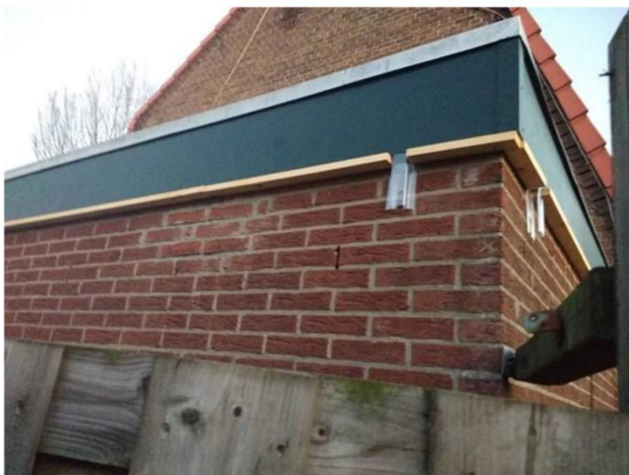
Details ongeschikt maken boeidelen met panlatten en exclusion flaps.
