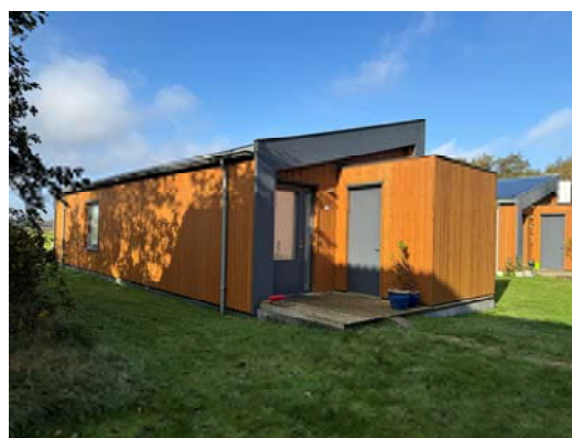
op nr. 135: 4 tijdelijke woonunits waarvoor verplaatsing is aangevraagd.
