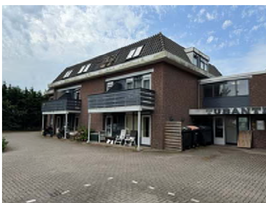
Op nr. 133: 27 bestaande hotelkamers
