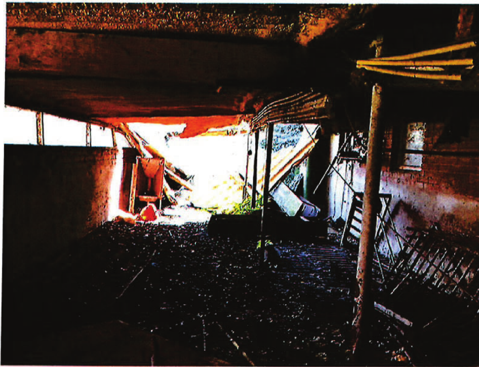
Foto 5 in stal 8 met ingestort gedeelte dak en asbest.
