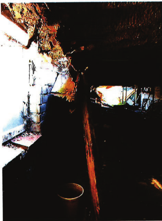
Foto 3 in stal 8 doorgezakt balk en op de achtergrond ingestort gedeelte dak met asbest
