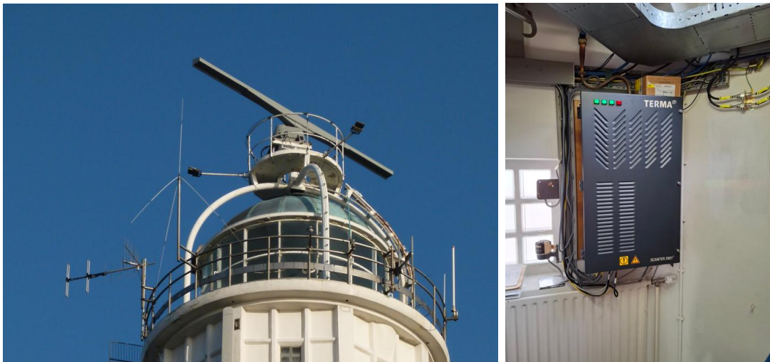
Figuur 3: Bestaande radarsensor en transceiver
