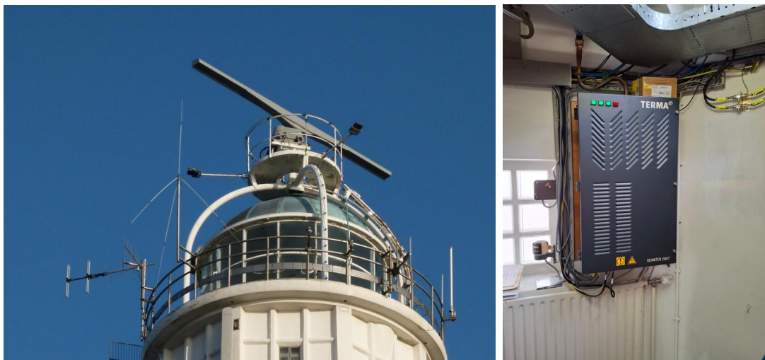
Figuur 5: Foto van de bestaande situatie.
