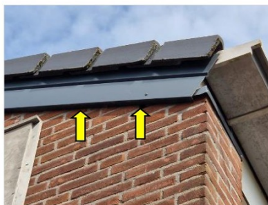
Figuur 4.5 Opening achter boeideel (gele pijlen).
