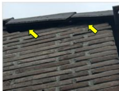
Figuur 2.6 Ruimte langs kantpannen (gele pijlen).
