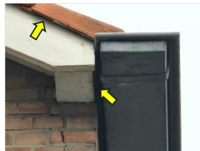
Figuur 2.8 Ruimte achter dakgoot en kantpannen (gele pijlen).
