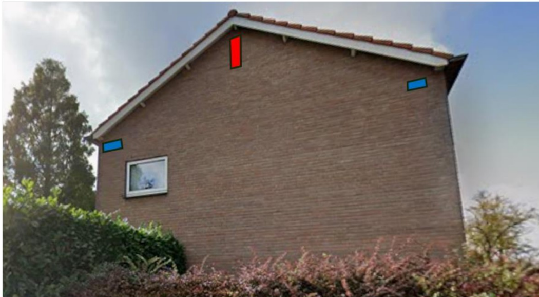
Figuur 6.6 Voorbeeld permanente mitigatie kopgevel Van Anrooijstraat 24. Rood=inbouwwleermuiskast; blauw=inbouwgiervaluwkast.
