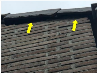
Figuur 4. Ruimte langs kantpannen (gele pijlen).
