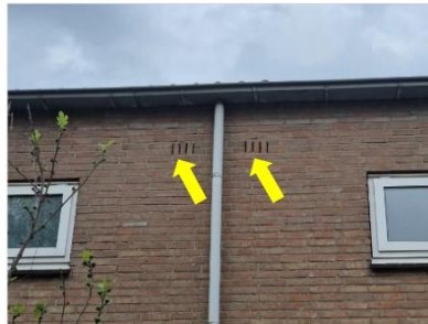
Figuur 5. Open stootvoegen (gele pijlen).
