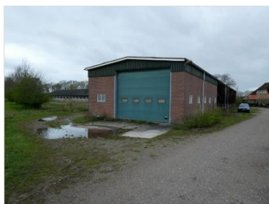
Figuur 2.4 Kopgevel van de zuidelijke kapschuur.
