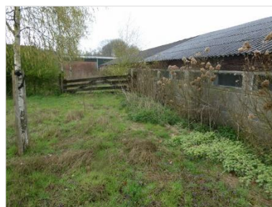
Figuur 2.5 Westzijde van de zuidelijke stal.
