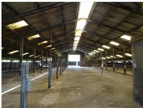
Figuur 5.1 Noordelijke schuur met open nokvorst.
