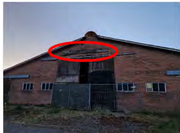
Figuur 3.10 Achter de plank aan de gevel werd een zomerverblijfplaats van 2 gewone dwergvleermuizen aangetroffen.
