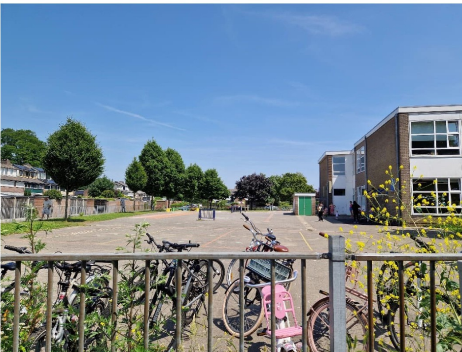
Figuur 1-4 Gebouw en plein in het projectgebied. Zicht vanaf het westen.
