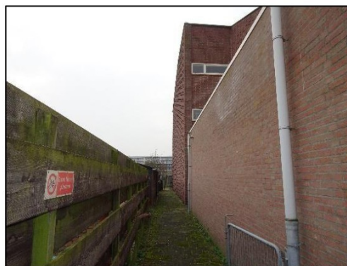
Aanzicht oostzijde kerk en aanwezige steeg;
