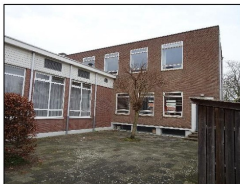
Aanzicht oostzijde bijgebouw;
