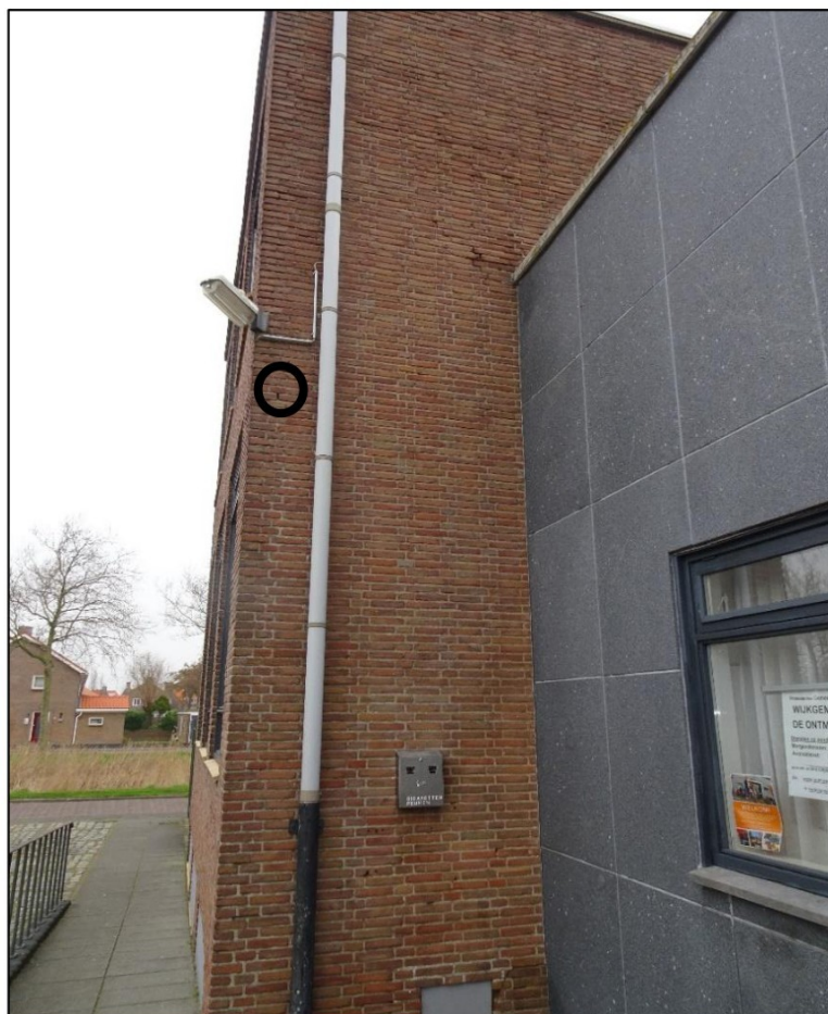
Locatie openstootvoeg zuidzijde bijgebouw.
