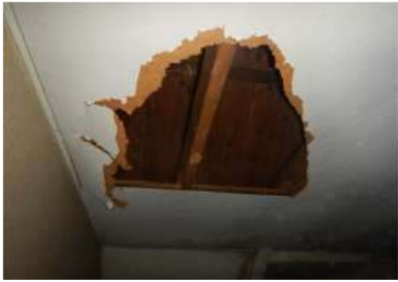
Zachtboard plafond en houten dakbeschot
