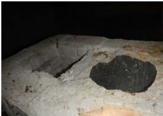
Gemetseld+getrokken schoorsteenkanaal
