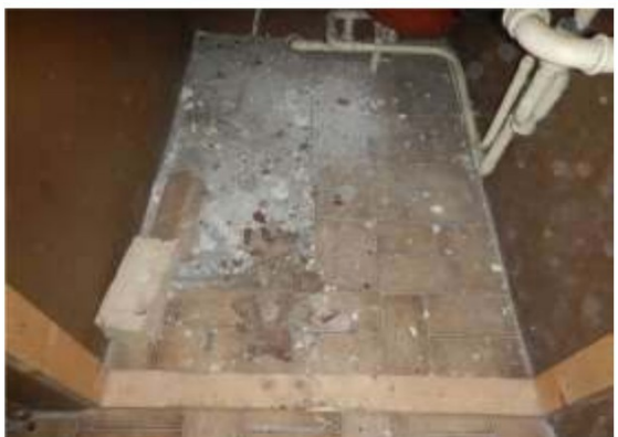
Keramische tegels op betonvloer
