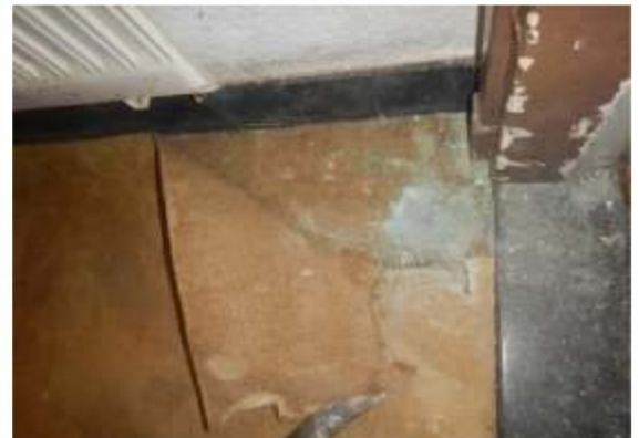
Linoleum op keramische tegelvloer
