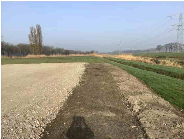
Foto 3 Toegepaste kantverhoging tegen puinverharding
