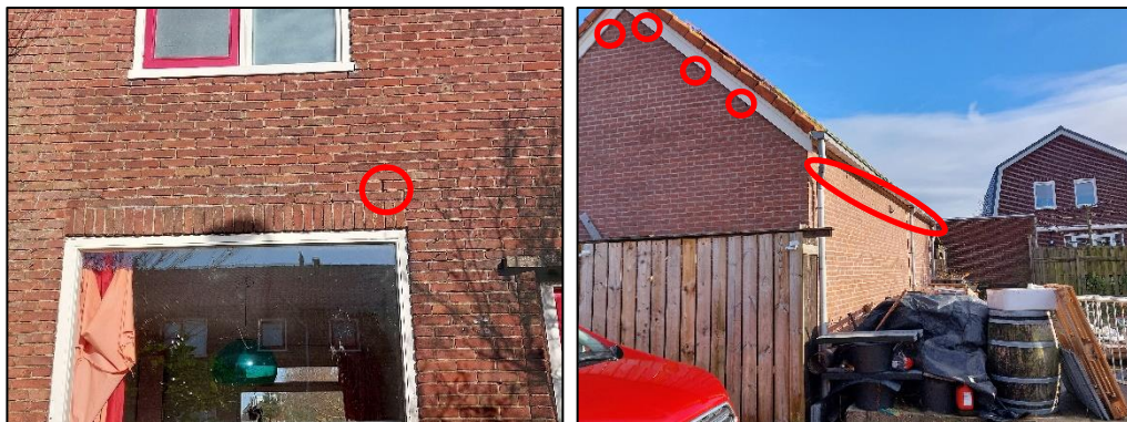
Figuur 4.2: Open voegen (rode cirkels) in de bebouwing die gesloopt wordt en bebouwing die in het plangebied direct grenst aan de ontwikkeling.
