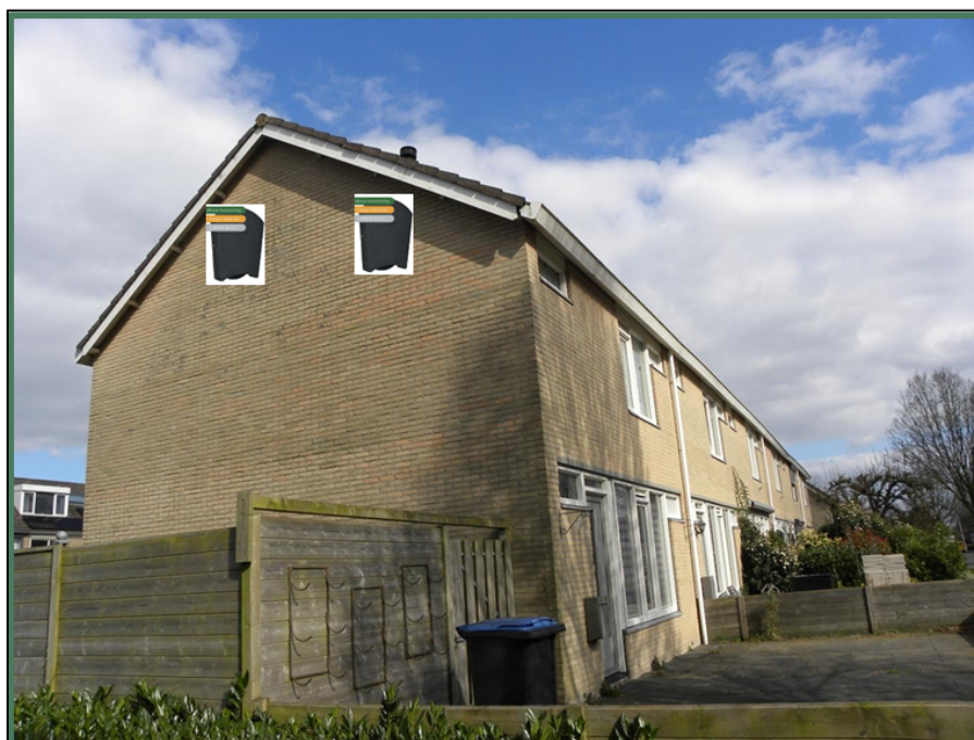
Figuur 8. Voorbeeld van de geplaatste tijdelijke vleermuiskasten aan de Kamerlingh Onnesstraat 38. Er zijn 2 tijdelijke vleermuiskasten aangebracht op 6 kopgevels.
