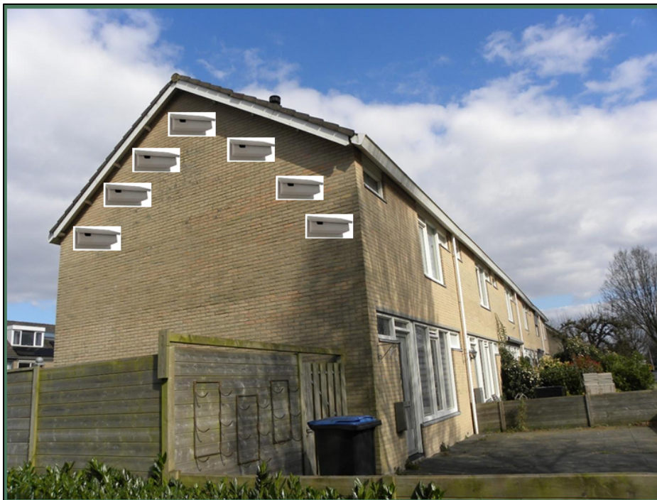
Figuur 3. Schematisch voorbeeld van de vervangende voorzieningen tijdens de werkzaamheden voor gierzwaluwen, aangebracht in een cluster van 7 stuks op de kopgevel.
