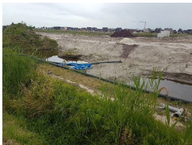
Figuur 3.13: Werkzaamheden ten oosten van het perceel.
