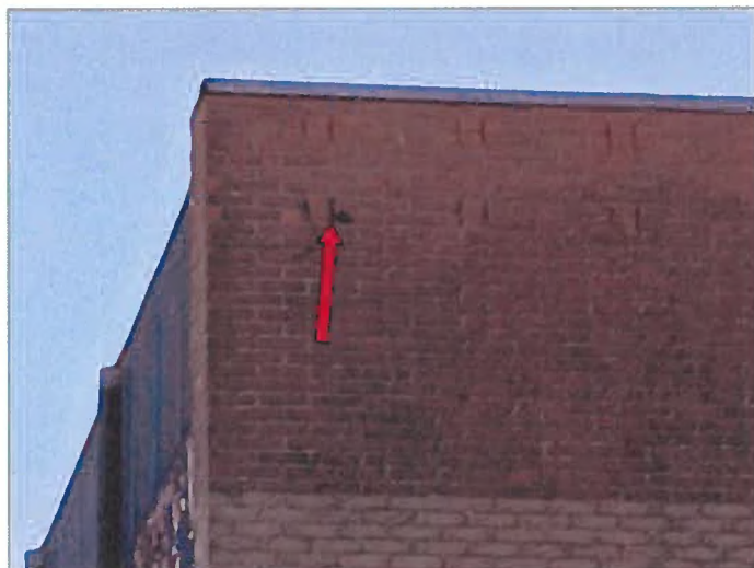
Figuur 2. De open stootvoeg in de spouwmuur (rode pijl) van de bebouwing geeft toegang tot voor vleermuizen geschikte achterliggende ruimtes. Tevens is de invliegende vleermuis naast de open stootvoeg te zien.
