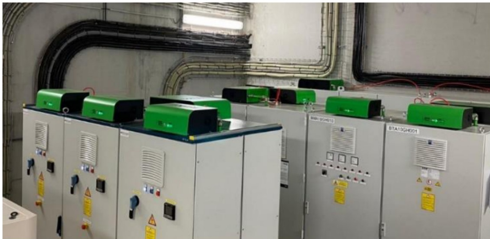
Figuur 3 Voorbeeld toepassing ExxFire-technologie.
