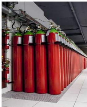
Figuur 4 Voorbeeld van batterij cilinders gecomprimeerd gas.
