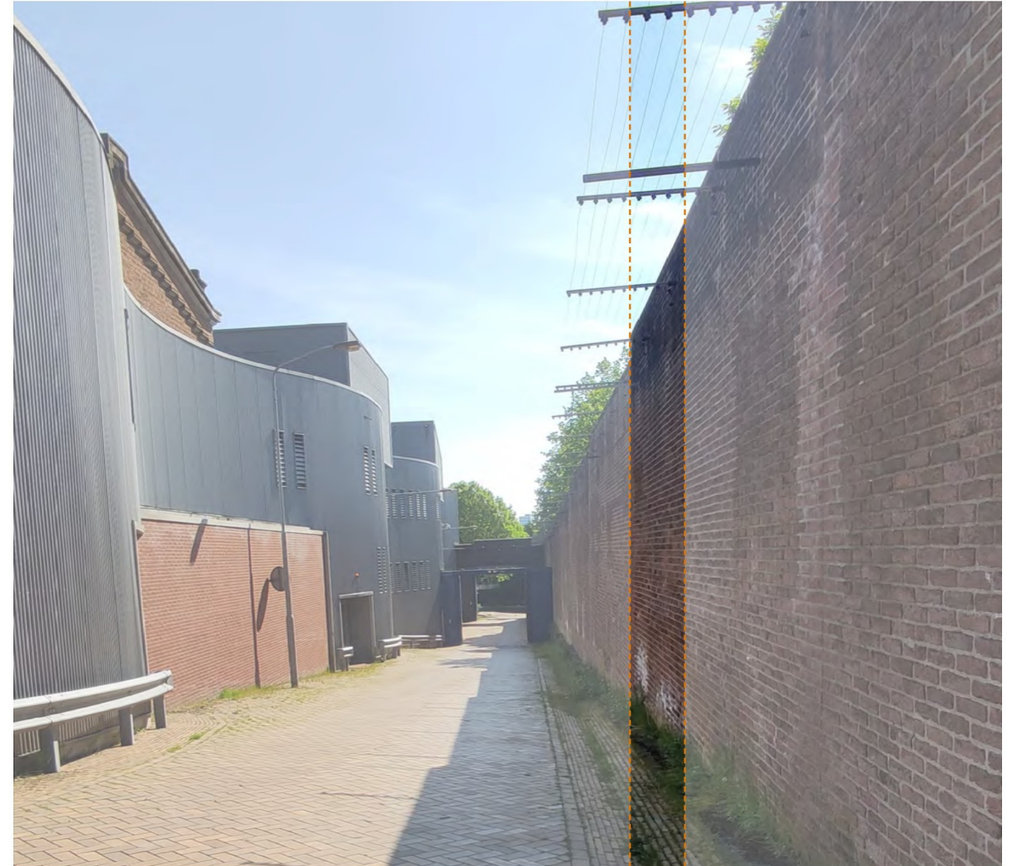
foto van de binnenkant
