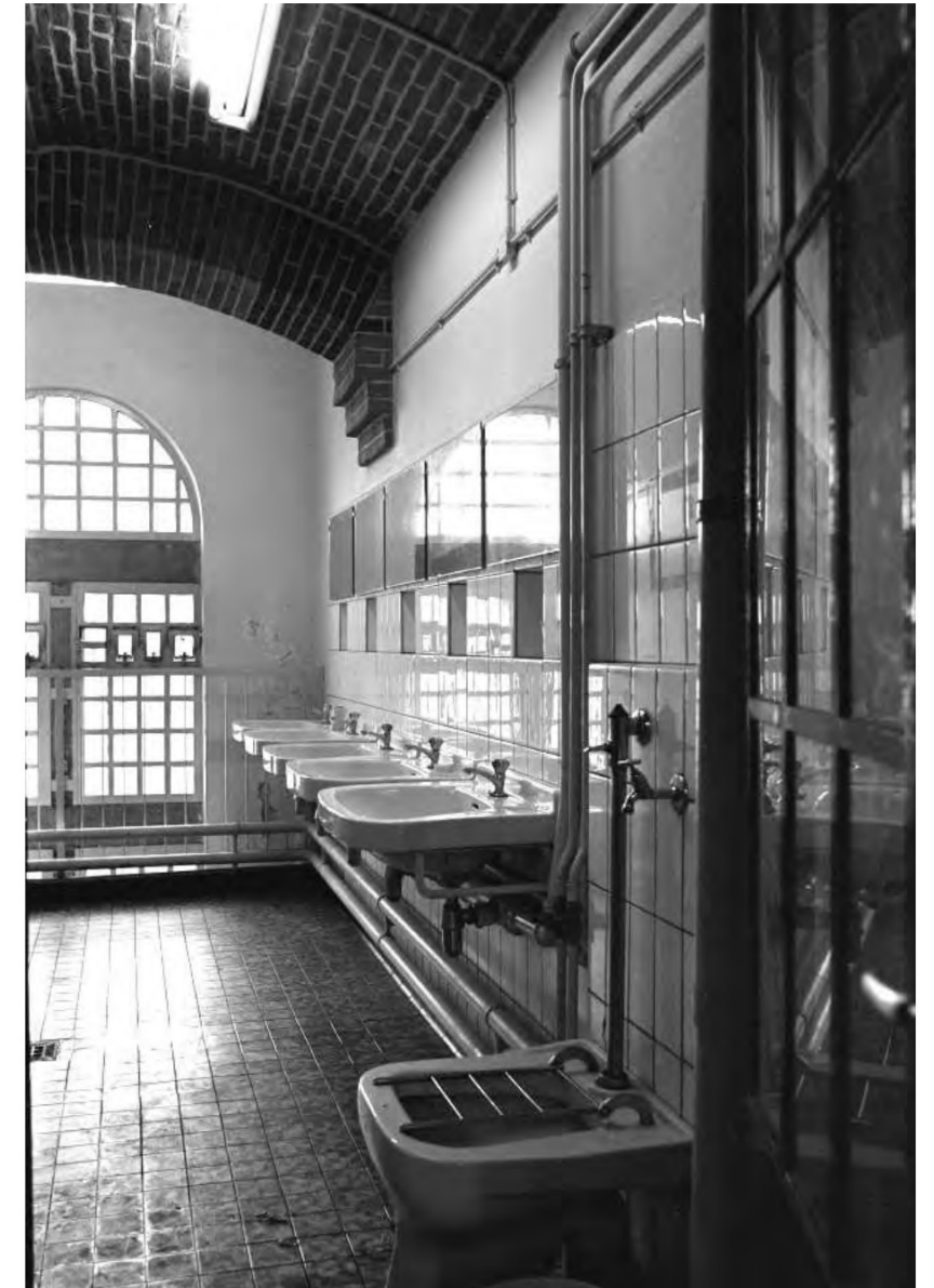
De sanitaire ruimten in de voormalige trappenhuizen in 1986
