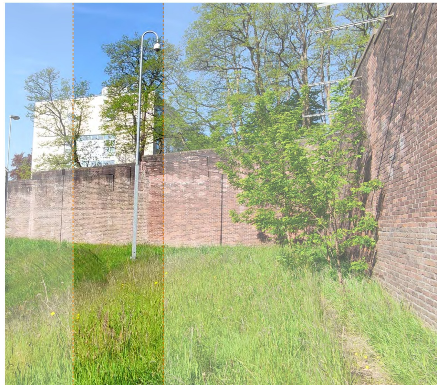
foto van de binnenkant
