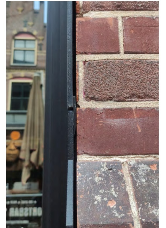
Het cortenstaal volgt de contour van de muur.
