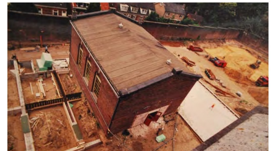
Tijdens de nieuwbouw op het terrein door Archivolt is het terrein opnieuw aardig vergraven ten behoeve van de aanleg van funderingsmuren en kelders. De voormalige kapel (hier in beeld) is in de nieuwe zuidvleugel opgenomen.
