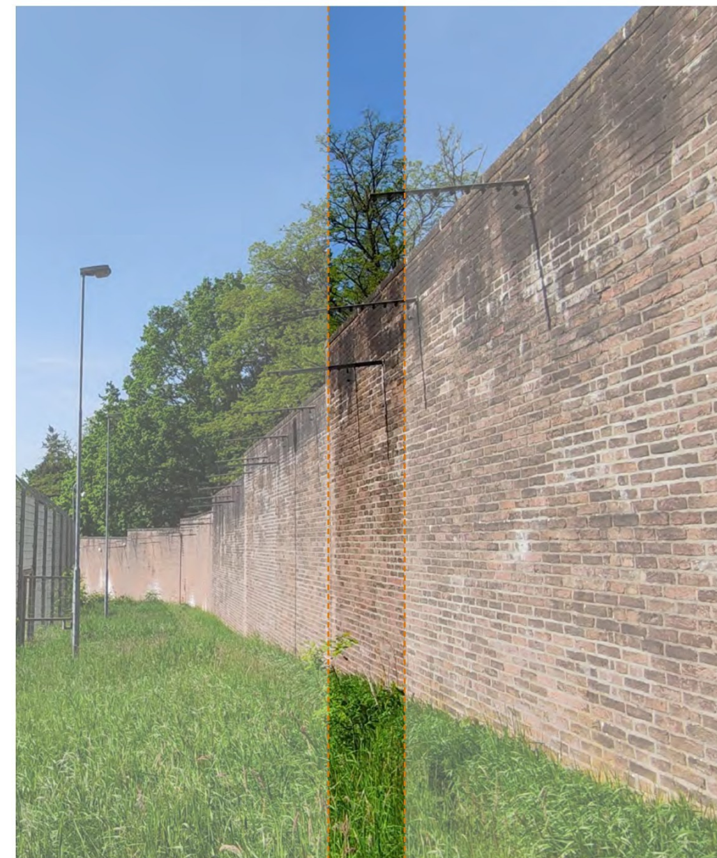
foto van de binnenkant
