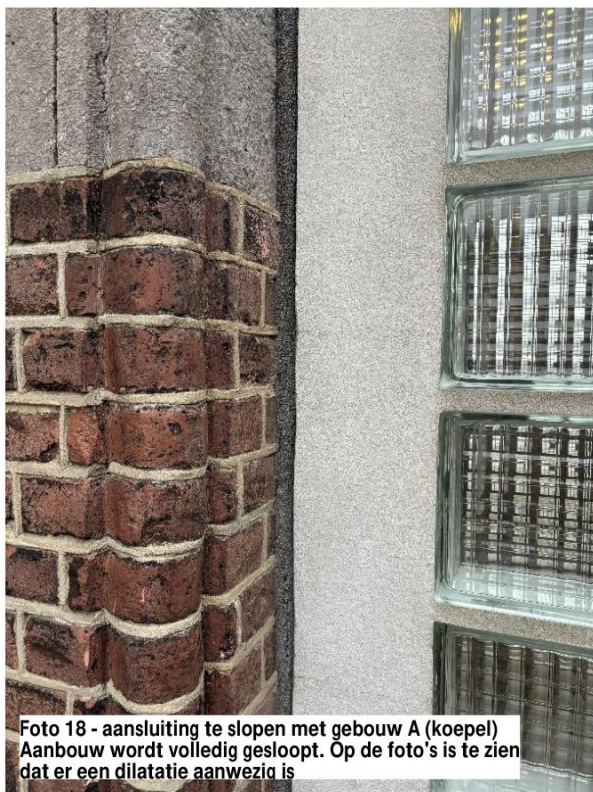
Foto 19 - aansluiting te slopen met gebouw A (koepel) Aanbouw wordt volledig gesloopt. Op de foto's is te zien dat er een dilatatie aanwezig is
