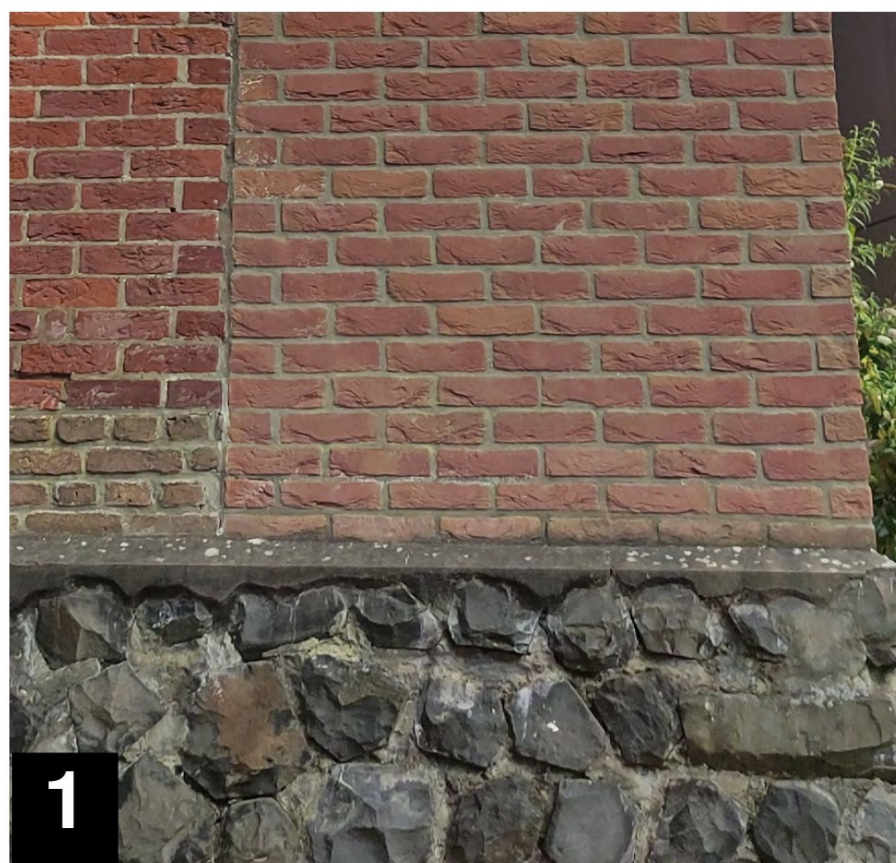
bestaande muur aan de zuidkant
