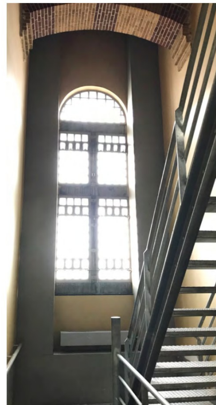
2e verdieping - binnenkant
