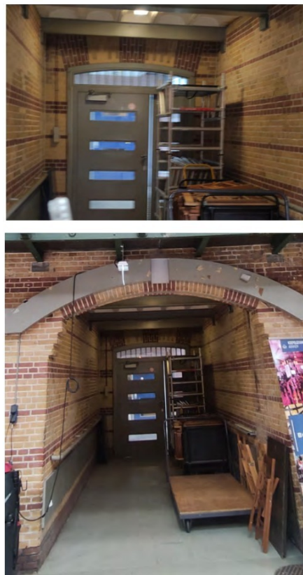
begane grond - binnenkant
