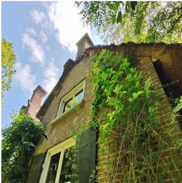
Klimplant aan de buitengevel van het gebouw. Potentiële nestplaats voor verschillende vogelsoorten.
