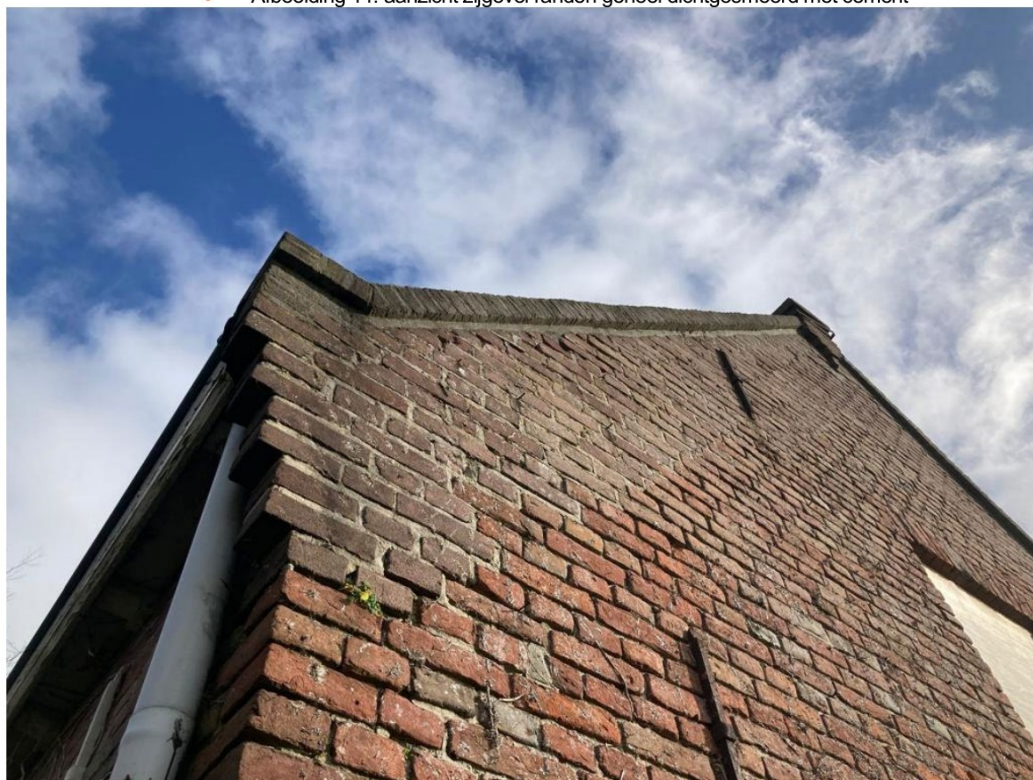
• Afbeelding 11: aanzicht zijgevel randen geheel dichtgesmeerd met cement
