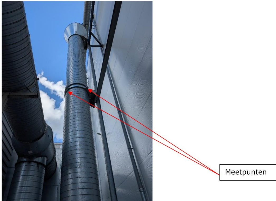
Figuur 2.4 Foto van de meetsituatie van de luchtfilters van de Dano-hal 1
