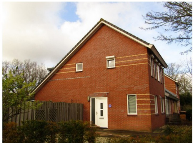
Kopgevel en voorgevel
