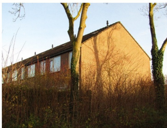
Kopgevel en achtergevel
