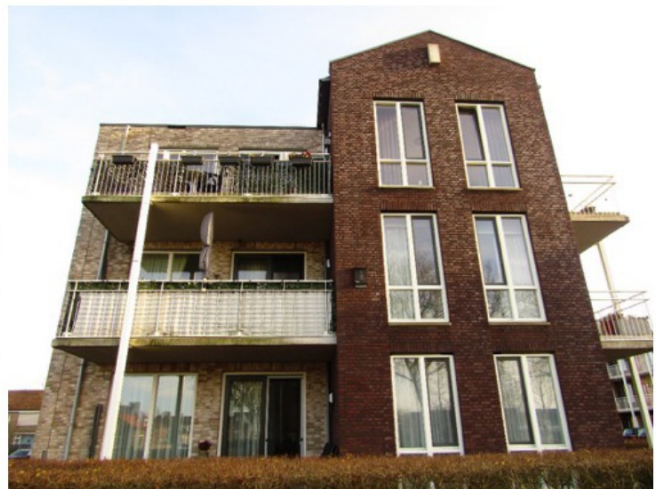
Kopgevel (met vleermuiskast)
