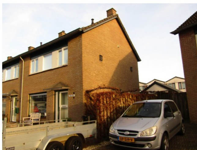
Kopgevel en voorgevel
