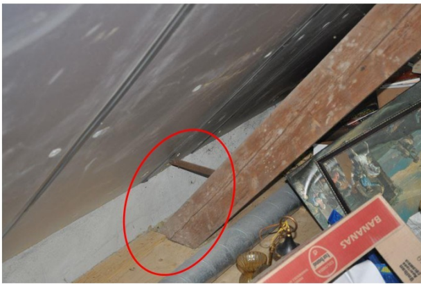
Afb. 116. Spantbenen en verankering
