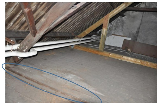
brede, lange sloffen en een vernieuwd spant.
