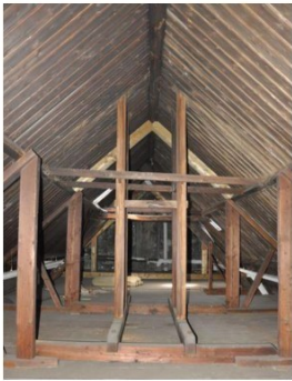
onderbouw en afb 93. windverband en spantbeen.
