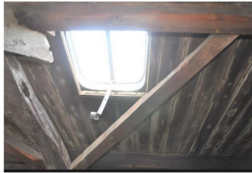
onderbouw en afb 93. windverband en spantbeen.
