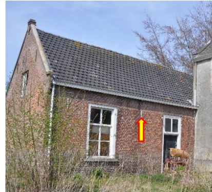
Afb. 14, 15 en 16. Foto 14 langsgevel van de westelijke aanbouw, met de gemarkeerde verhoging, foto 15 eindgevel met herkenbare verhoging en foto 16 verhoging strokend met bovenzijde raam en deur gelijk de oostzijde.
