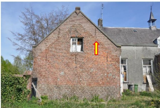
Afb. 14, 15 en 16. Foto 14 langsgevel van de westelijke aanbouw, met de gemarkeerde verhoging, foto 15 eindgevel met herkenbare verhoging en foto 16 verhoging strokend met bovenzijde raam en deur gelijk de oostzijde.
