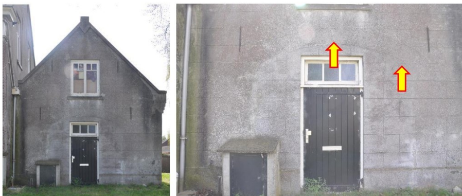
aanbouw. Op foto rechts de segmentboog met pijlen aangegeven.
