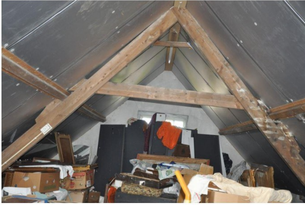
Afb. 115. A-spanten en gordingen.
