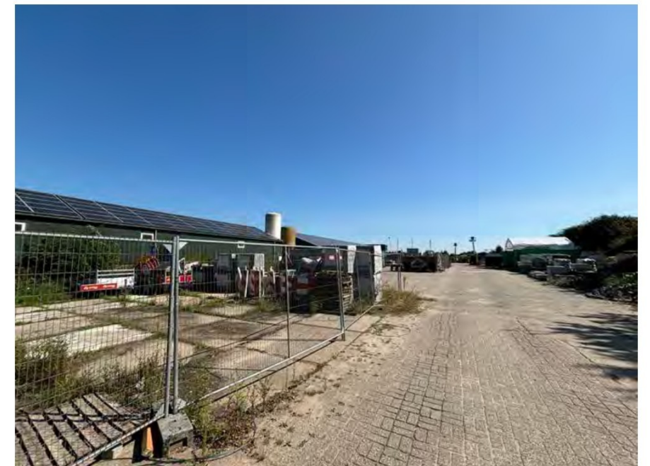
Te slopen stallen J en M met PV-panelen op het dak
