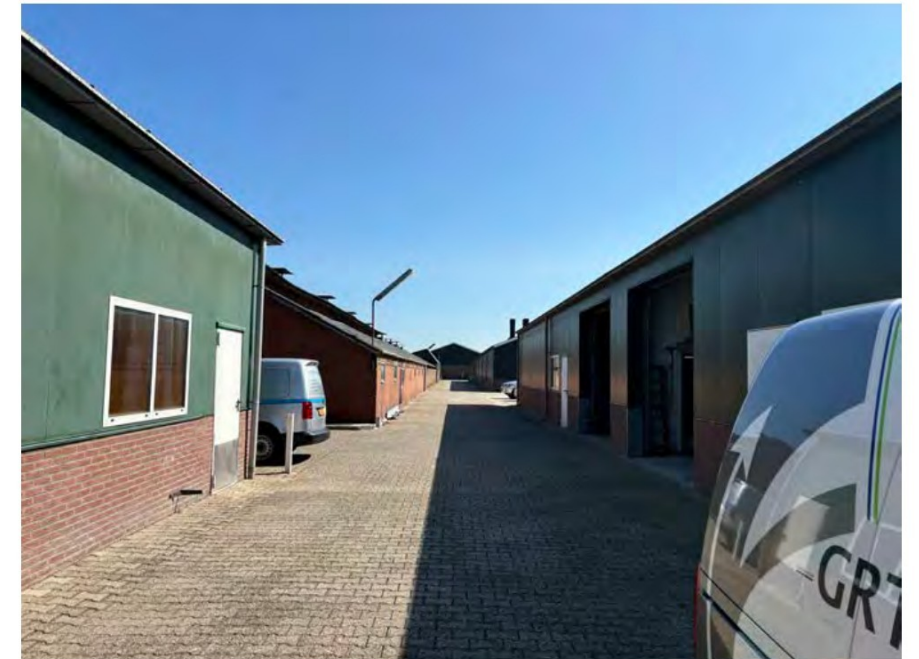
Op de voorgrond links en recht staan de twee bedrijfshallen welke behouden blijven, daarachter bevinden zich de te slopen stallen.
