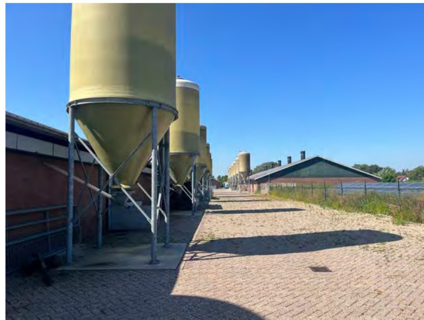
Te slopen stallen I en M
