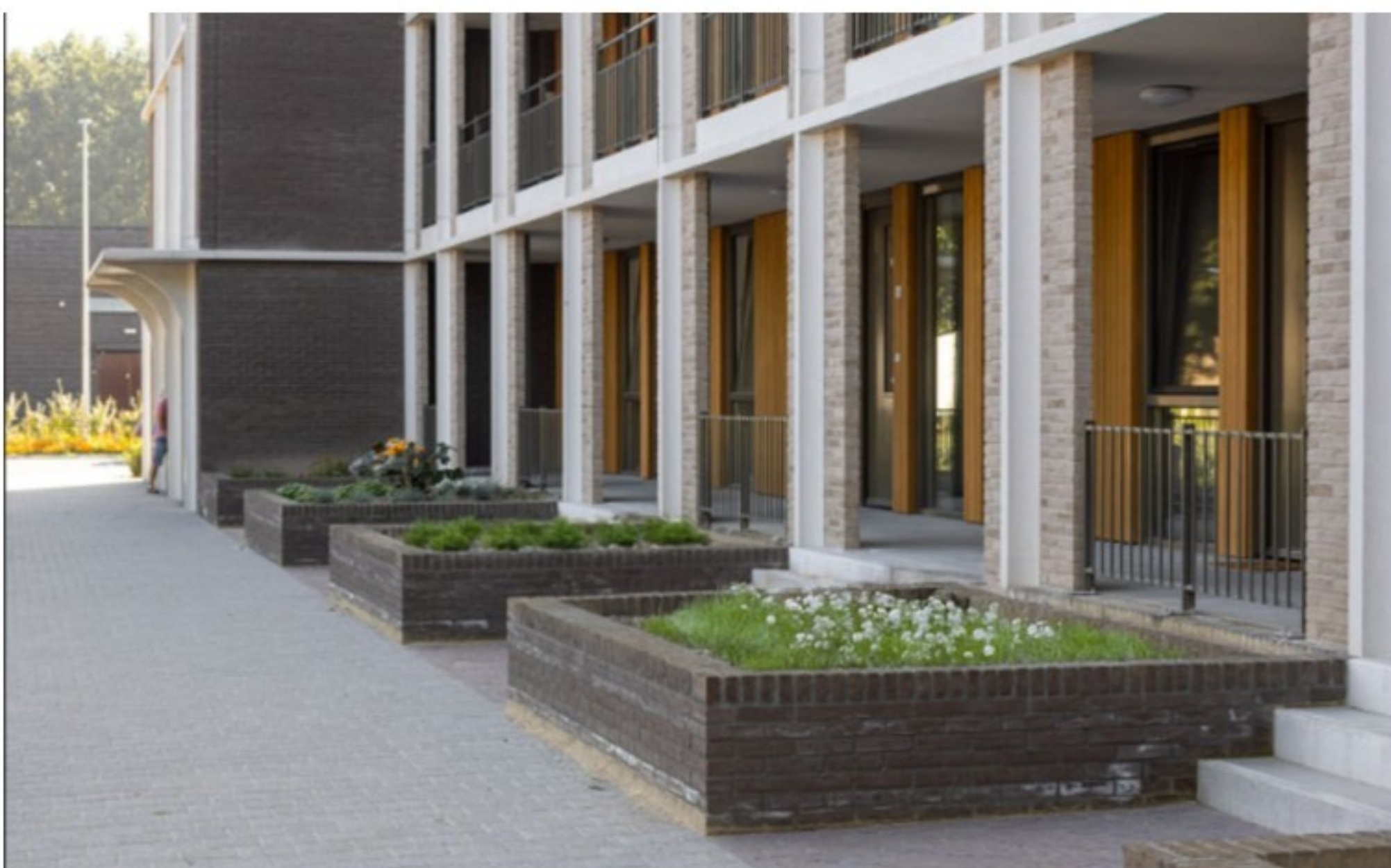
De begane grond sluit zich duidelijk af van de parkeerplekken in de tussenruimte, maar de bergingen zijn wel bereikbaar.
