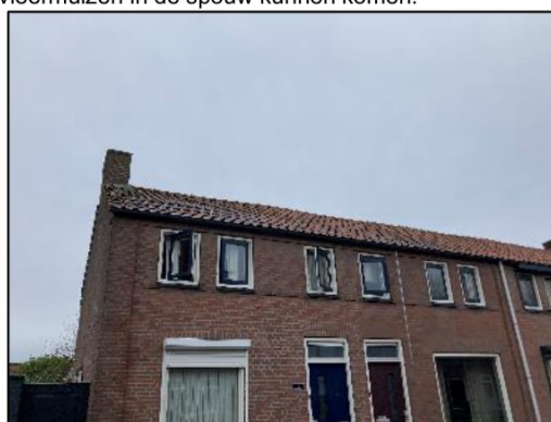
Foto 16. Complex 203. Huismussen kunnen via de dakgoot onder de pannen komen.
