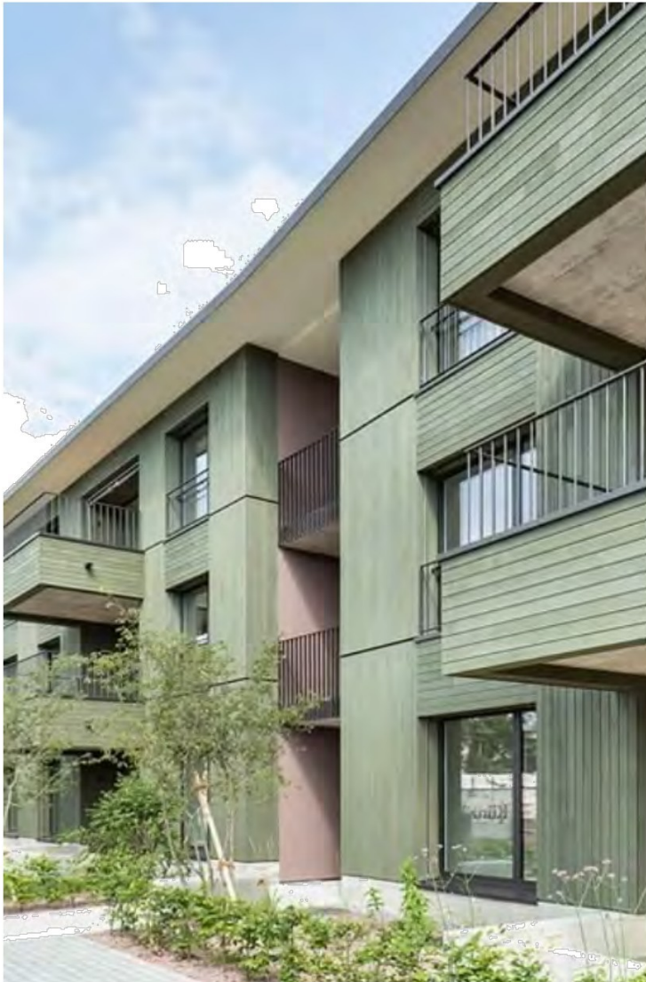
Entree herkenbaar en leesbaar in de gevel.
