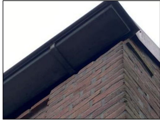
Foto 14. Complex 203. Ruimte onder dakgoot waardoor gierzwaluwen de pannen kunnen bereiken en vleermuizen in de spouw kunnen komen.
