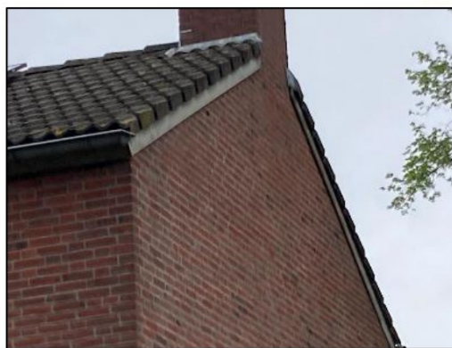
Foto 2. Complex 106. Ruimte voor huismus onder de pannen via de goot, en ruimte voor gierzwaluw onder de pannen via de overstekende gevel pannen. Voor vleermuizen is er toegang tot de spouw via de ruimte onder de dakplaten en randpannen
