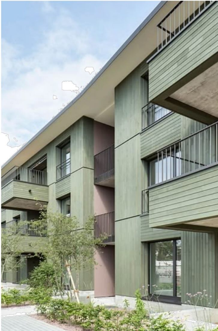
Entree herkenbaar en leesbaar in de gevel.
