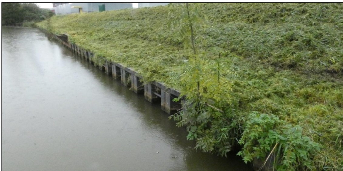
Figuur 9: De oever heeft een metalen beschoeiing en beschikt niet over rietruigte of andere begeleidende elementen zoals bosjes of houtwallen. .
