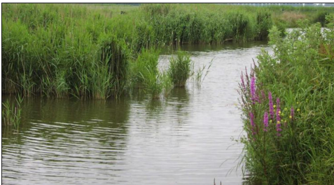
Figuur 9: Voorbeeld van een vernauwing in de sloot. Bron: Waterschap Hollandse Delta.
